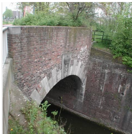
Oostzijde van de duiker onder de Bosscherweg
