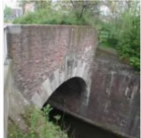
Oostzijde van de duiker onder de Bosscherweg
