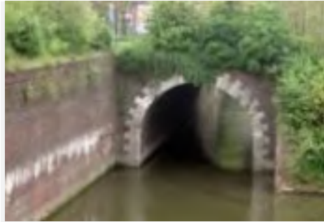
Westzijde van de duiker onder de Bosscherweg
