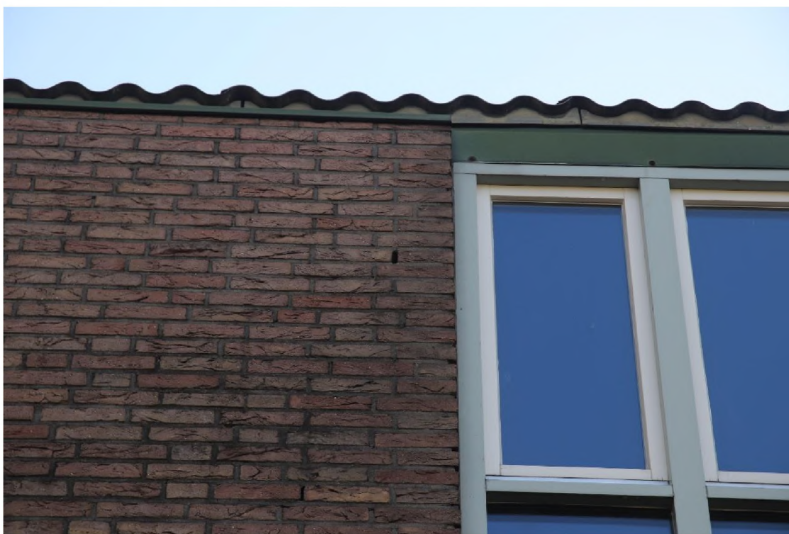
Foto 1: Open stootvoegen die geschikt kunnen zijn voor vleermuizen
