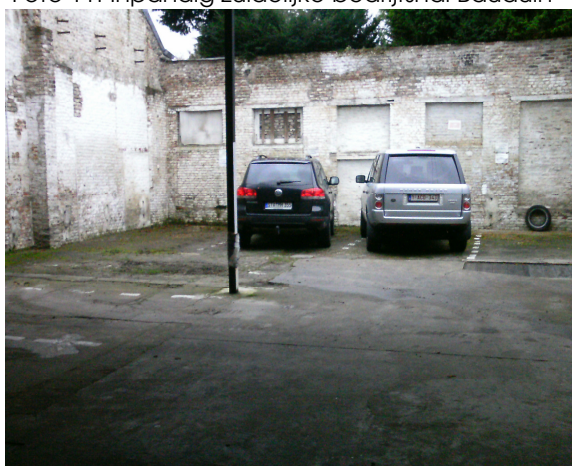
Foto 11. Inpandig zuidelijke bedrijfshal Bauduin
