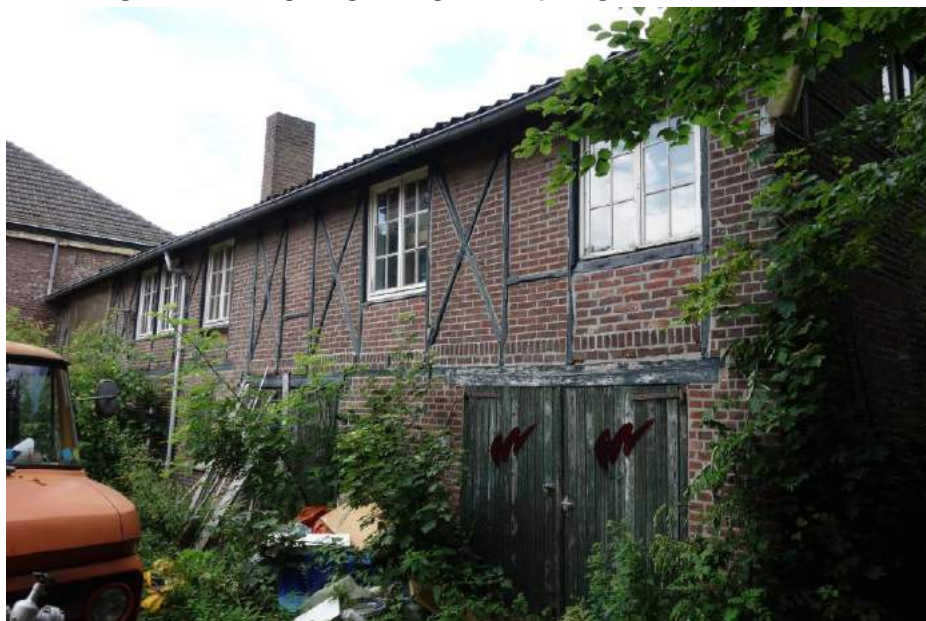
Het achterste deel van deze vakwerkgevel behoort tot de in 1866 toegevoegde schuurvleugel van de boerderij. Het voorste deel betreft een iets latere uitbreiding.
