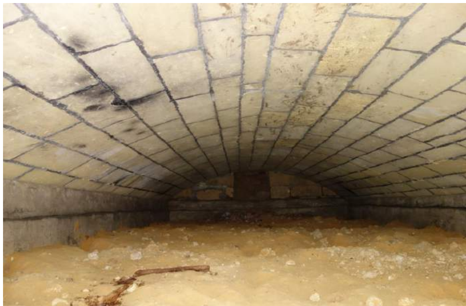
Een van de kelders met tongewelf van mergel onder de aanbouw bij de westvleugel.
