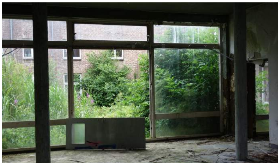
Zicht op de ontvangstruimte achter de entree in de zuidvleugel gezien richting het noorden.
