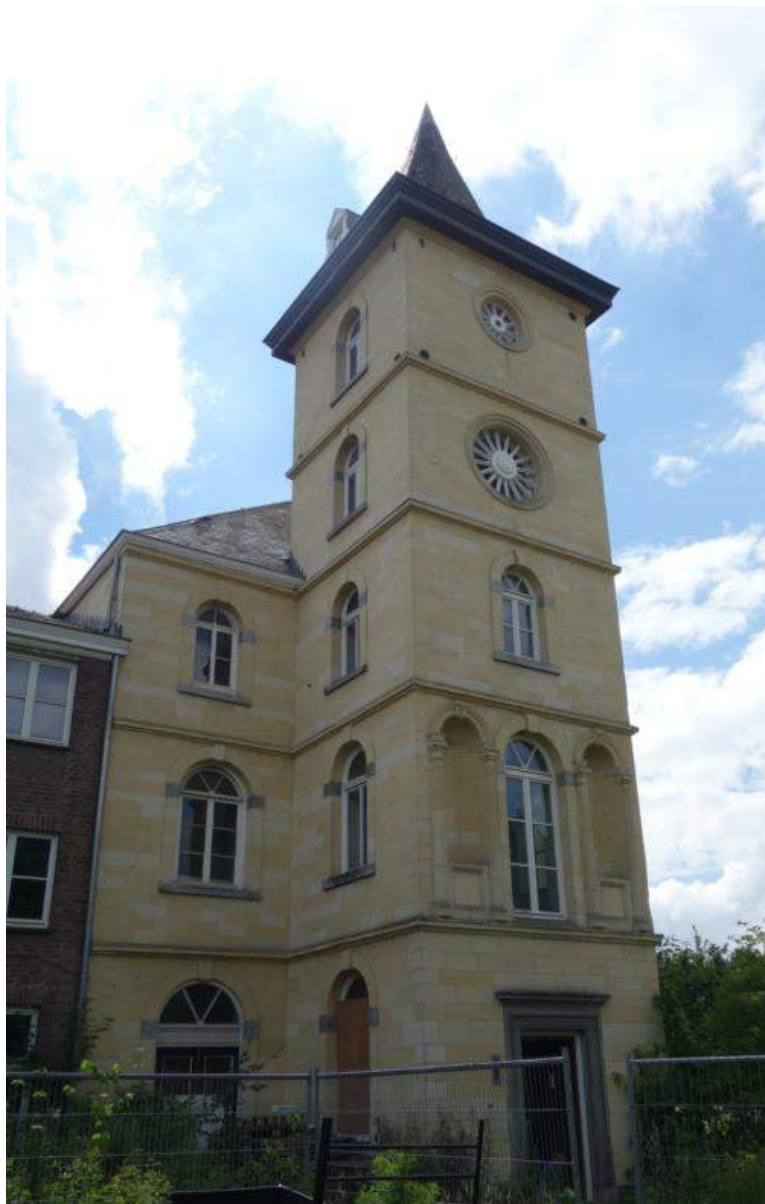
De noordelijke hoektoren met aanbouw gezien richting het zuiden.
