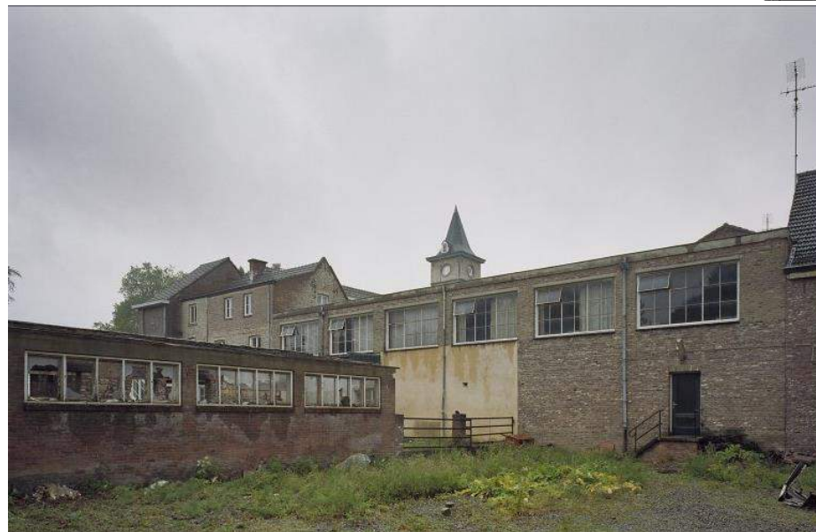
Zicht op de oostvleugels en de ruïneuze schuur links. G. Dukker 2004 Beeldbank RCE
