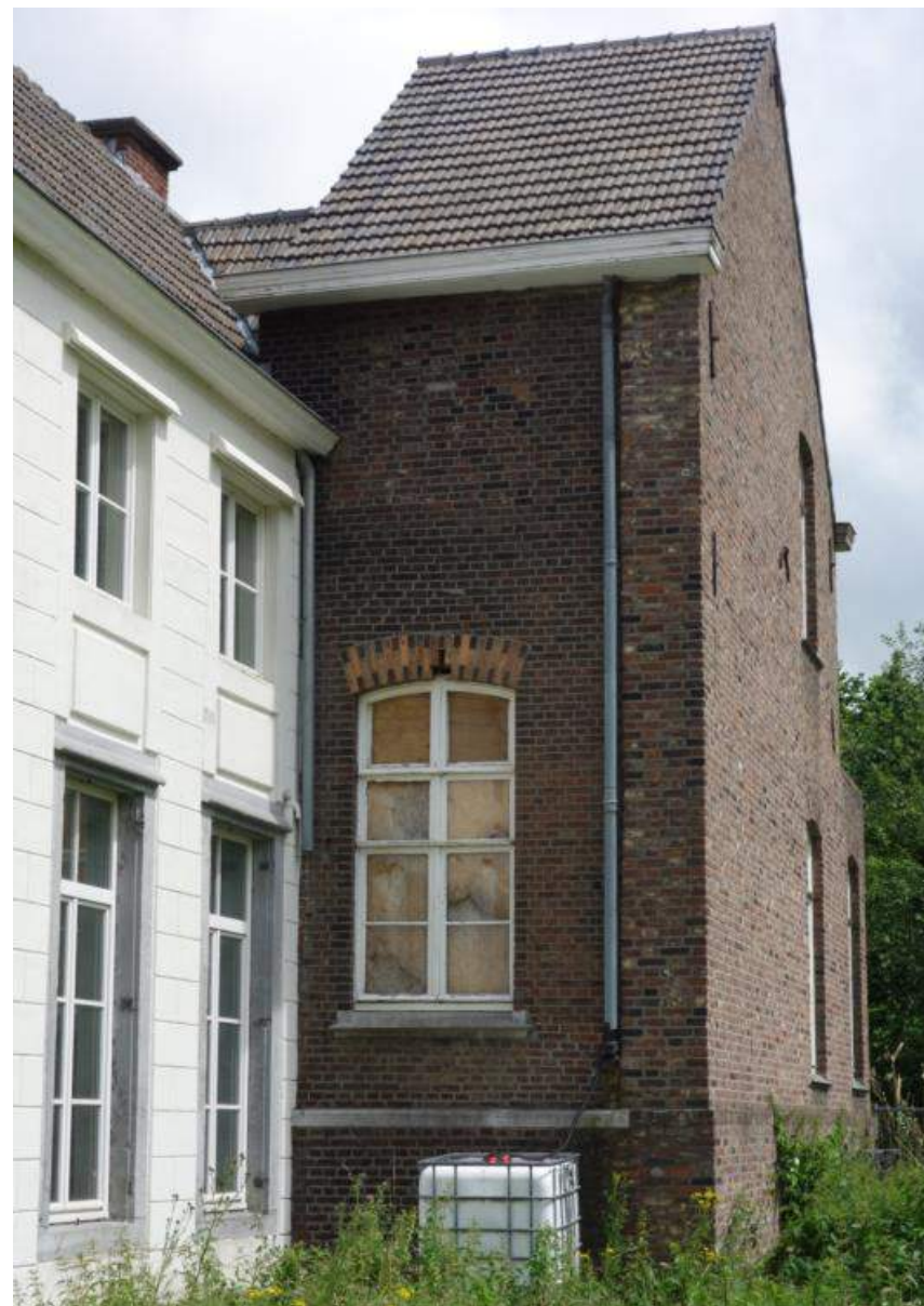
Zicht op de ingekorte westelijke zijgevel van de kloostervleugel met nog een venster met een boog in gekleurde verblendsteen.
