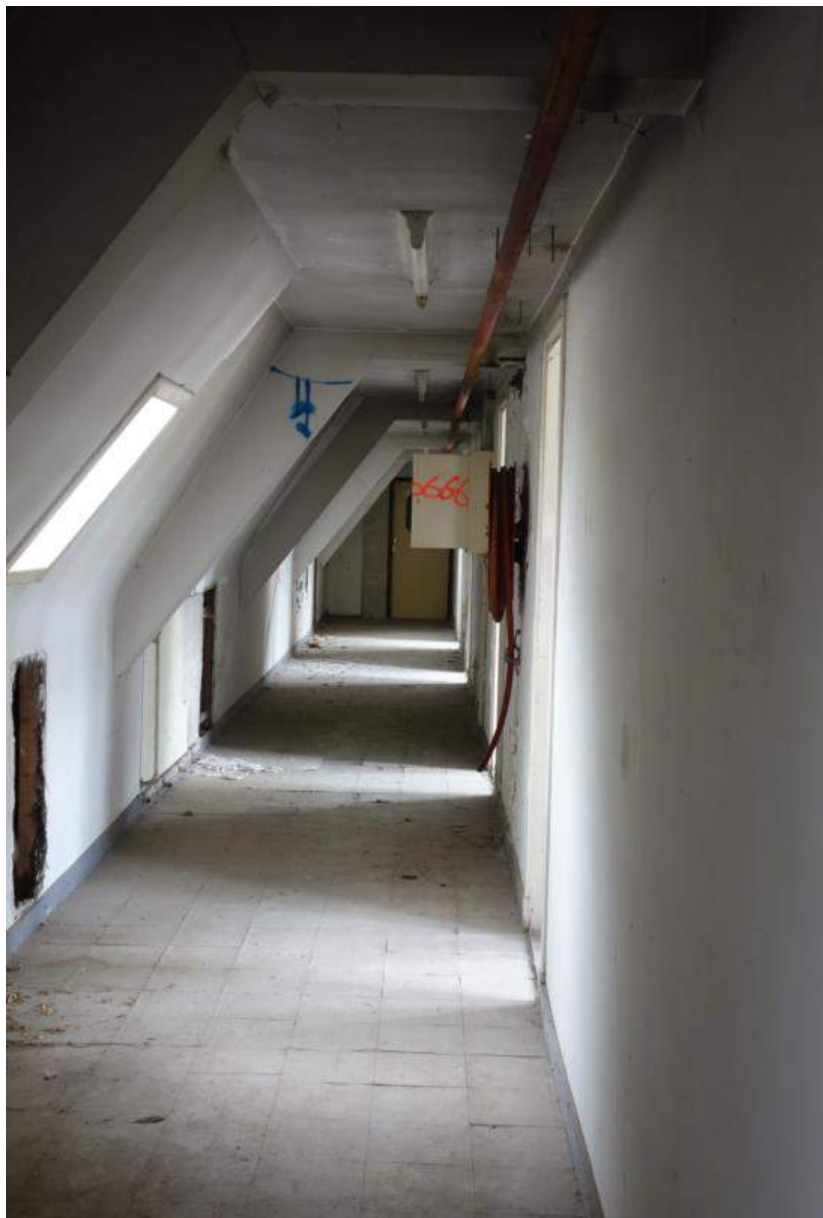
Gang op de tweede verdieping van de zuidvleugel gezien richting het westen.
