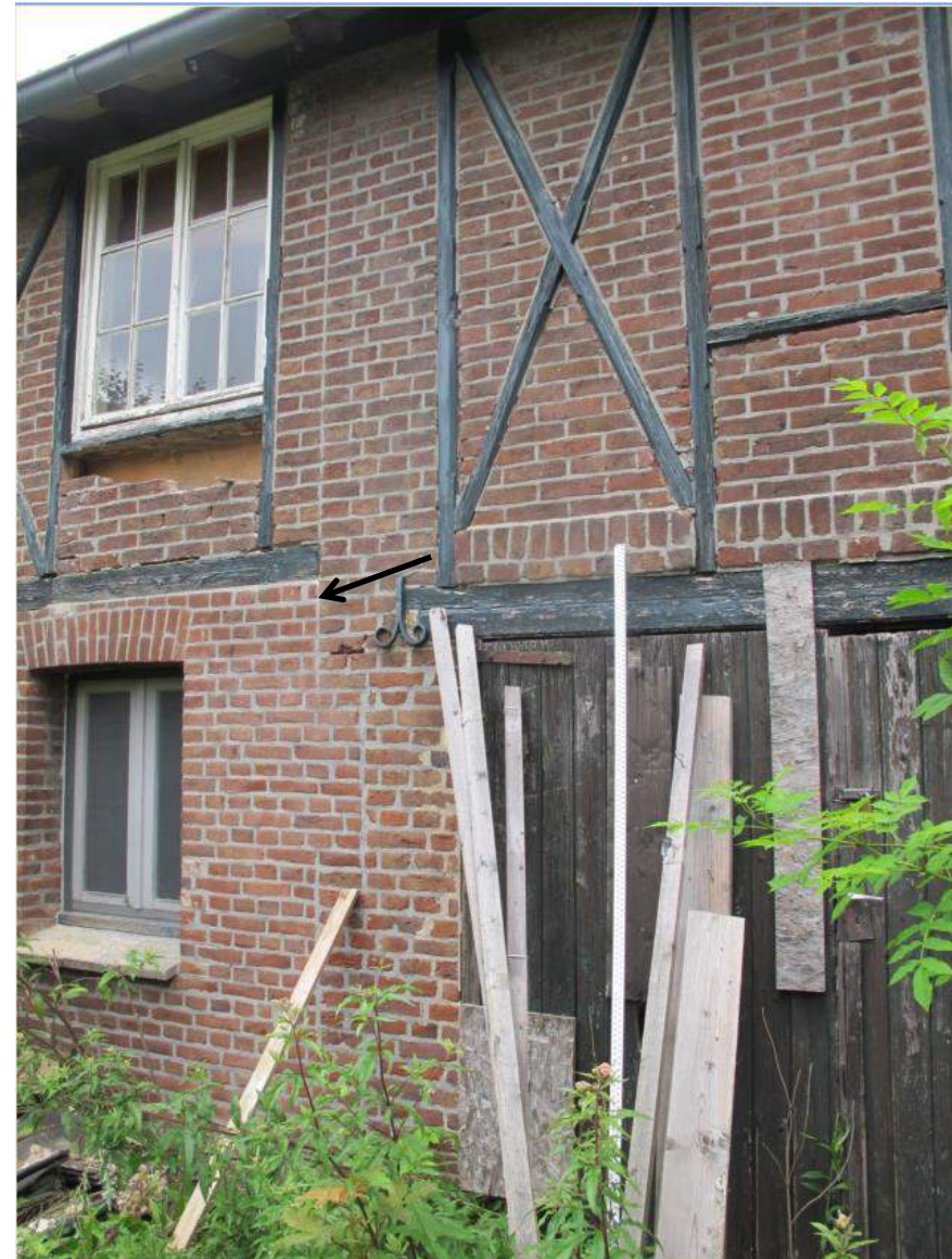
Een van de twee staldeuren in de uitbreiding van 1880. Bij de pijl is de vertanding te zien van het muurwerk van 1880 in dat van 1866.
