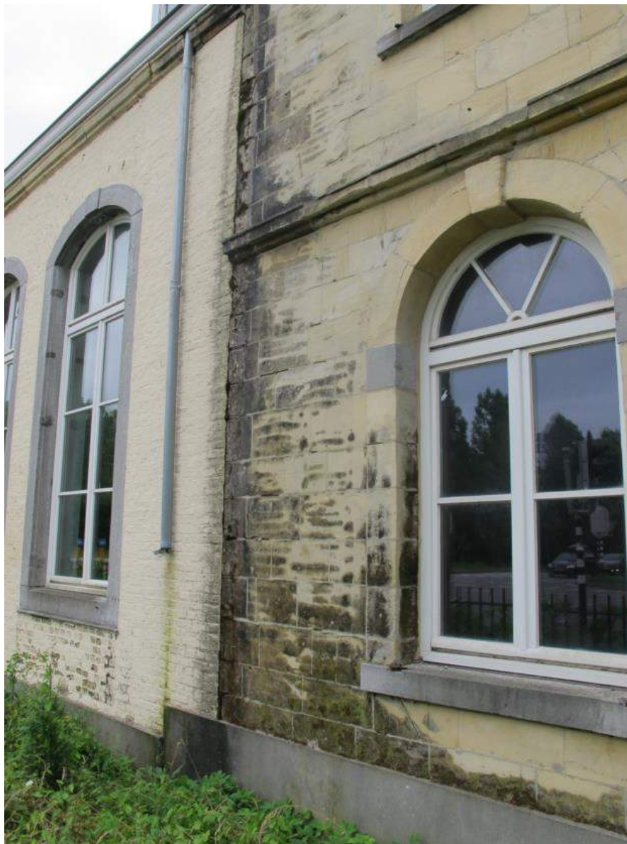
De overgang van het middendeel van de zuidvleugel naar de aanbouw van de hoektoren uit 1866. Links een van de hoge rondboogvensters aan de rechterzijde van het risaliet.
