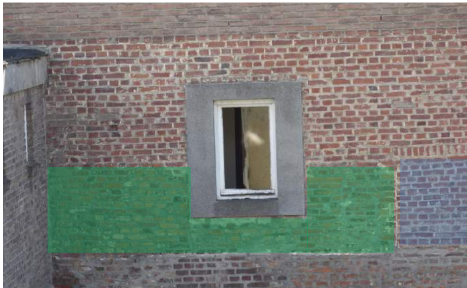
Detail van de binnenzijde van de zuidvleugel met de dichtzetting van een 18de -eeuws venster (blauwe vlak) in het oorspronkelijke metselwerk (groene vlak).
