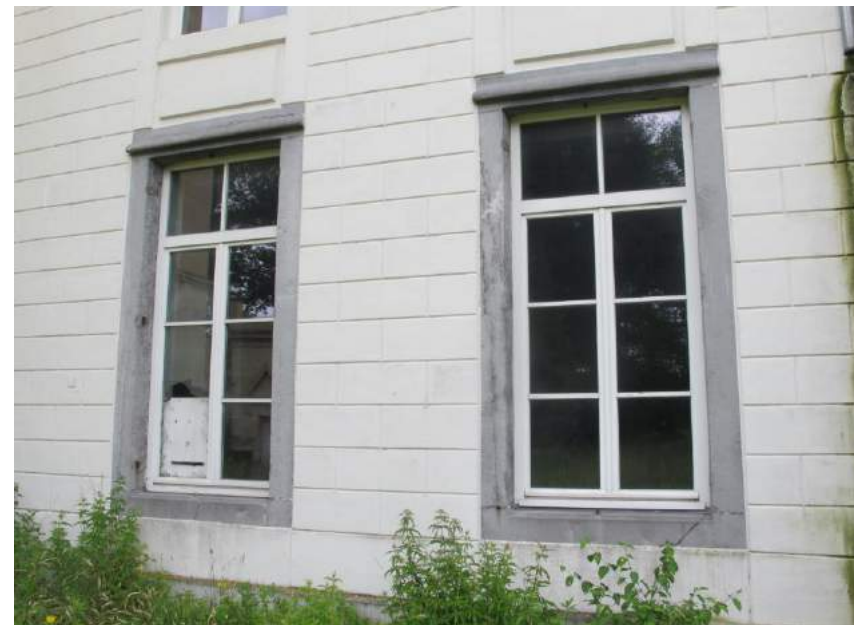
Detail van de vensters met hardstenen omlijsting op de begane grond aan de linkerzijde van het middenrisaliet.
