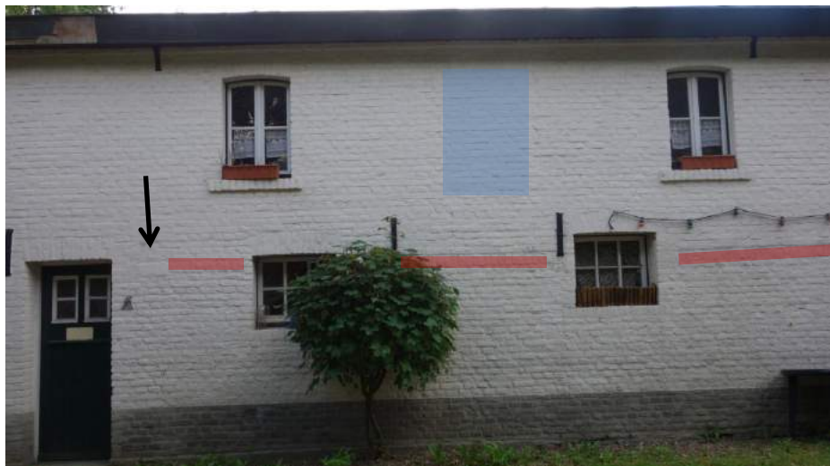
Zicht op de noordelijke zijgevel van de schuur uit 1866 en 1880 met door de blauwe vlakken gemarkeerde vensterdichtzettingen. De rode vlakken markeren de rollaag en bij de pijl het blok natuursteen.
