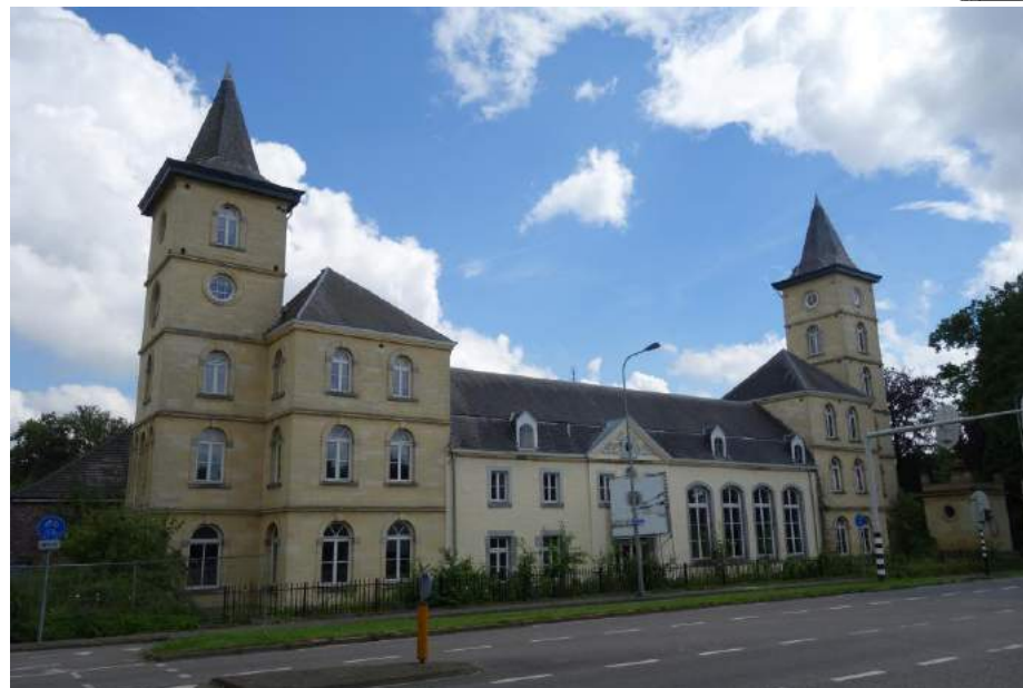
Door de toevoeging van de mergelstenen paviljoens en torens en de middenrisaliet met fronton met de naam Grande Suisse werd het aanzicht van het complex vanaf de straat grondig gewijzigd.
