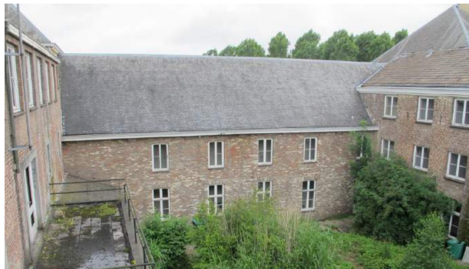
Zicht op de binnenzijde van de westvleugel. De gevel lijkt na 1880 opnieuw te zijn opgemetseld.
