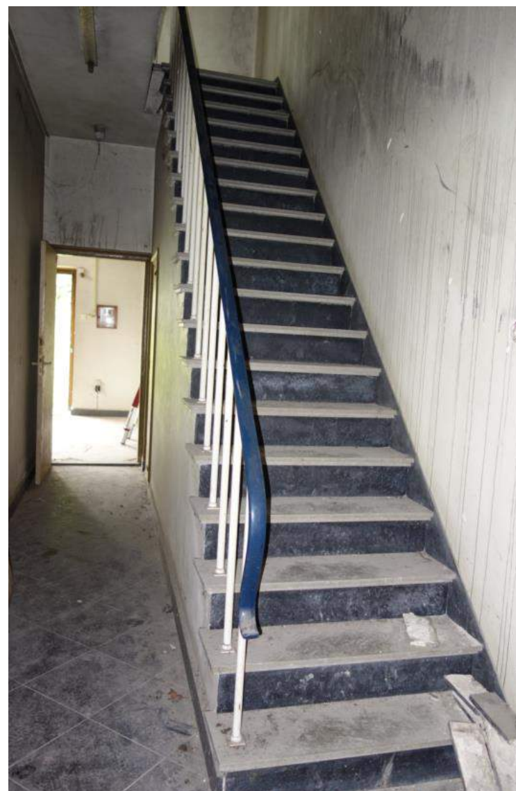
Het trappenhuis uit 1961 aan de noordzijde op de begane grond van de westvleugel.
