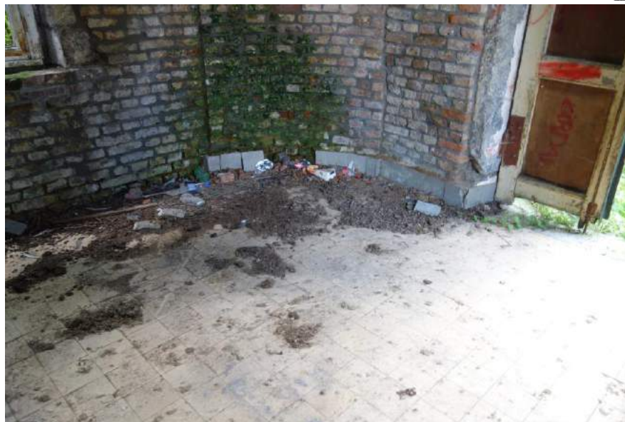
De vloer van het oostelijke paviljoen.
