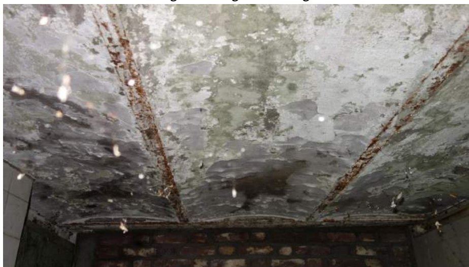
Detailopname van de troggewelven in de kelder onder de kloostervleugel.
