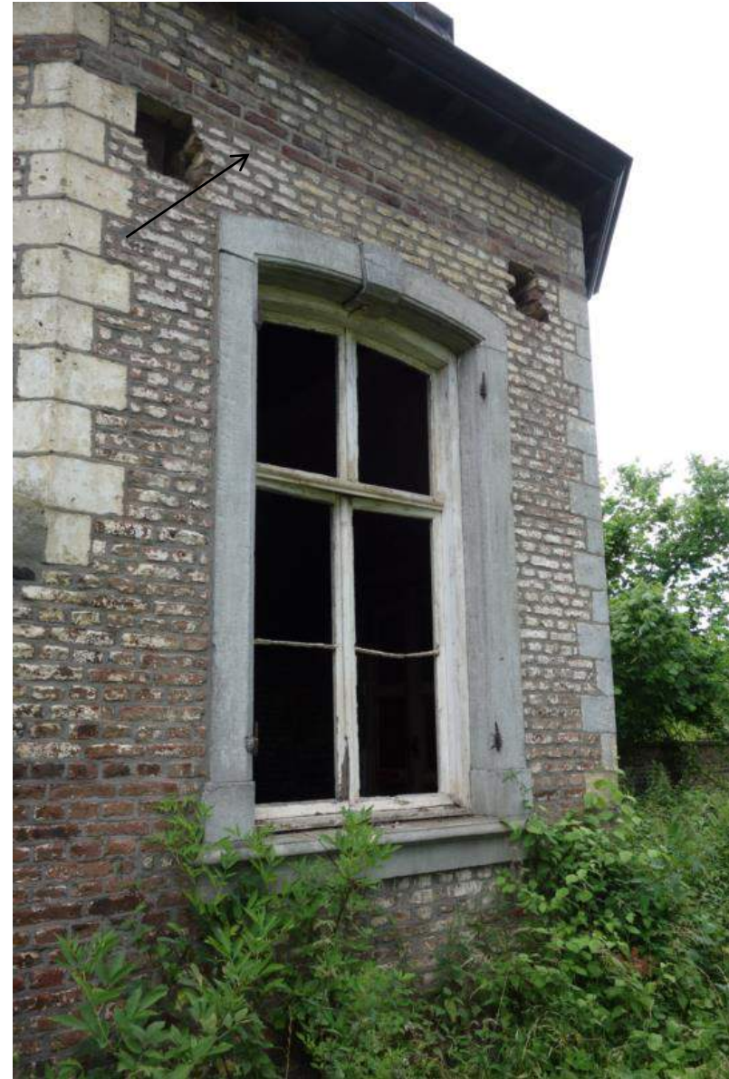
Detail van het venster aan de noordzijde in het oostelijke paviljoen met de positie van de houten lijst in het muurwerk (zwarte pijl).
