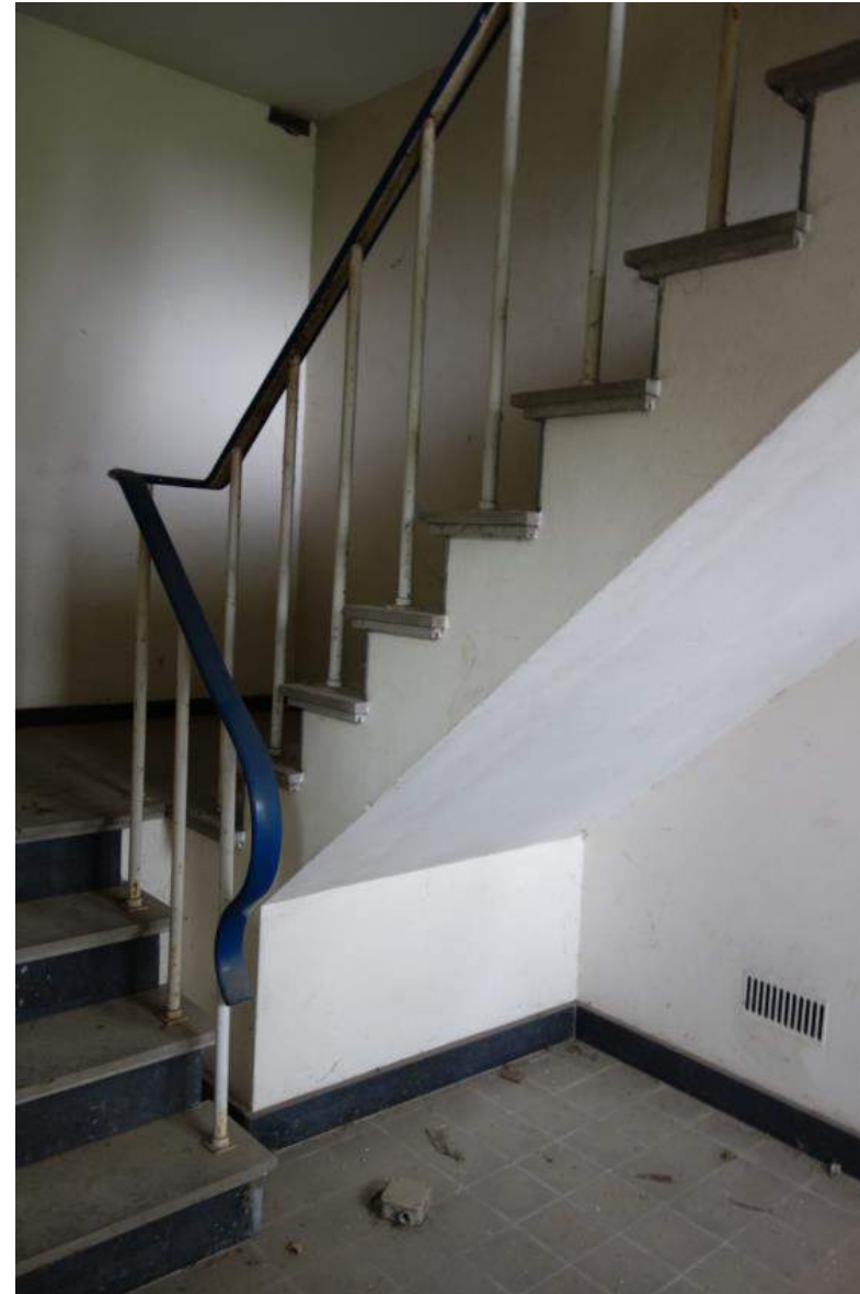
Het trappenhuis met moderne trap uit 1961 aan de westzijde van de noordvleugel.
