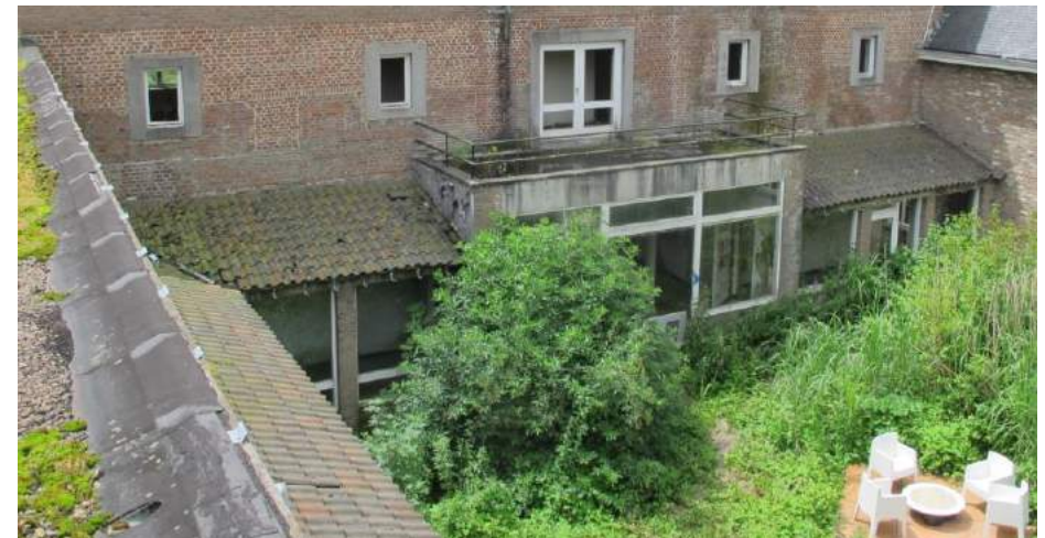
Zicht op de gang die wordt onderbroken door een in 1961 aangebracht balkon tegen de oorspronkelijke gevel
