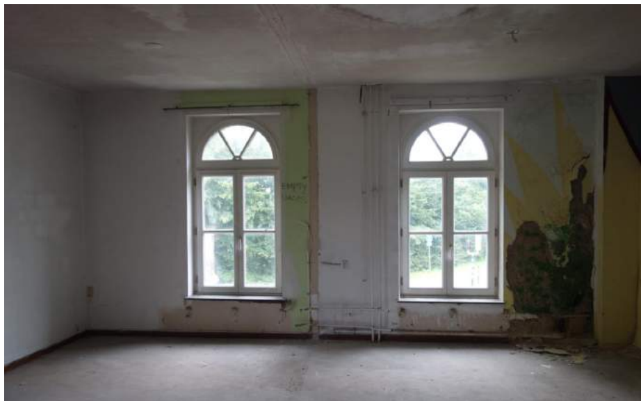
De ruimte op de verdieping in de zuidelijke aanbouw.
