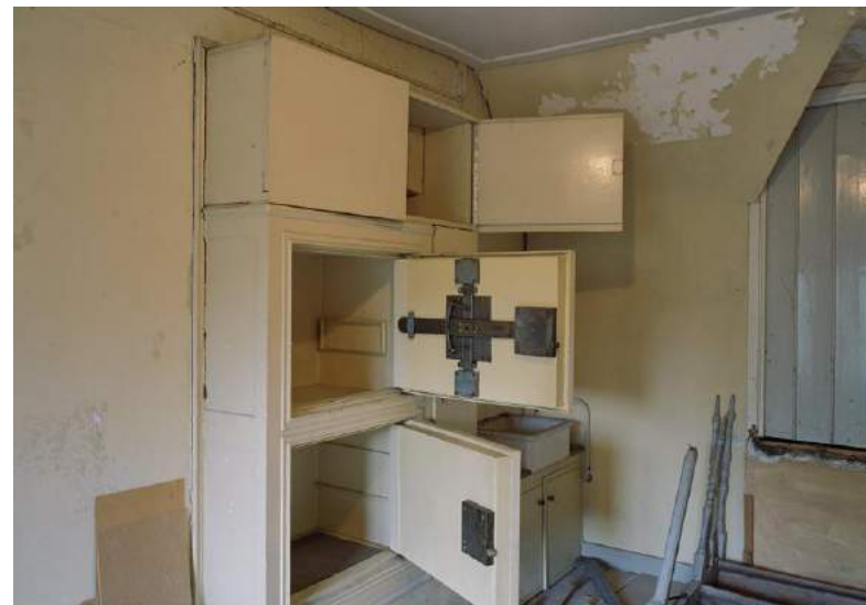
Brandkast op de zolder van het oostelijke deel van de zuidvleugel. G. Dukker RCE 2004
