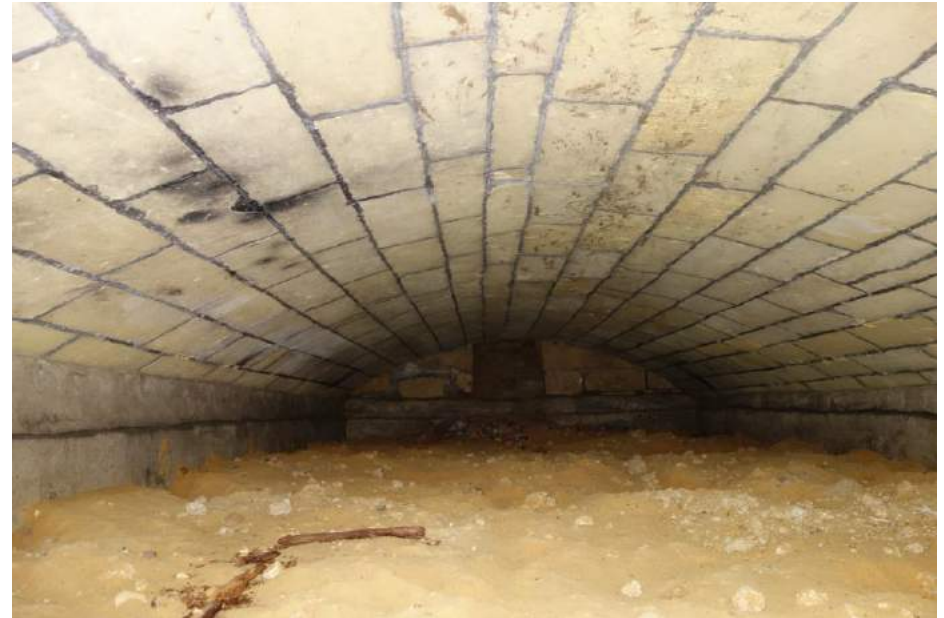
Zicht in de zuidelijke kelder van de westvleugel.
