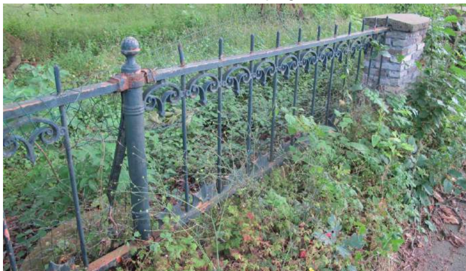
Het vermoedelijk 18de -eeuwse hekwerk op de westelijke tuinmuur.
