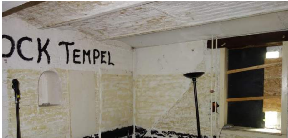
Troggewelven boven de begane grond van een van de ruimtes in het bouwdeel ten oosten van de noordvleugel.
