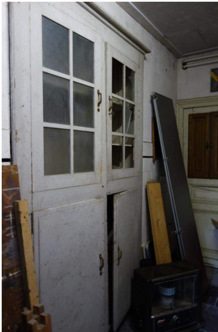
Detail van de inbouwkast met architraaflijst in de ruimte met de 18 de -eeuwse natuurstenen tegelvloer aan de oostzijde van het complex. De onderzijde van de kast is nu een keldertoegang.
