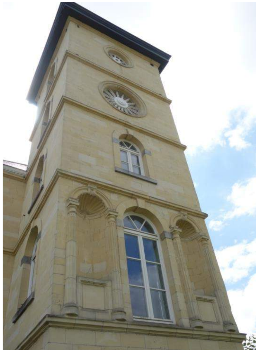
Detail van de noordzijde van de noordelijke toren met de nissen en het aan de onderzijde doorlopende venster op de eerste verdieping.
