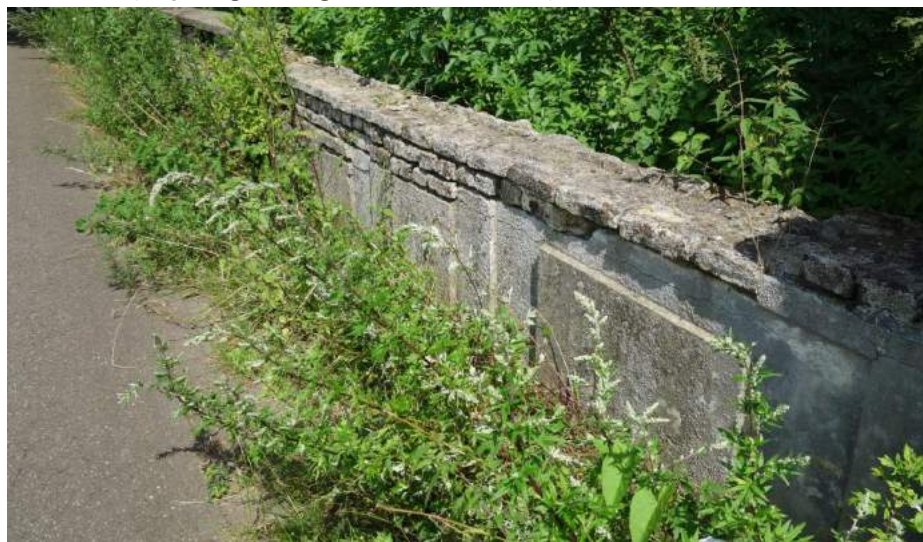
De 18de -eeuwse tuinmuur met het gepleisterde paneelwerk.
