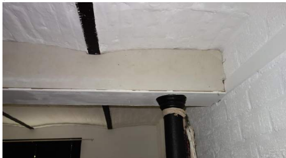
Detail van de ruimte met de stalen kolom in de schuur uit 1866.
