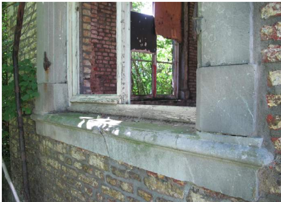
Detail van de oorspronkelijke 18de -eeuwse hardstenen omlijsting en onderdorpel.
