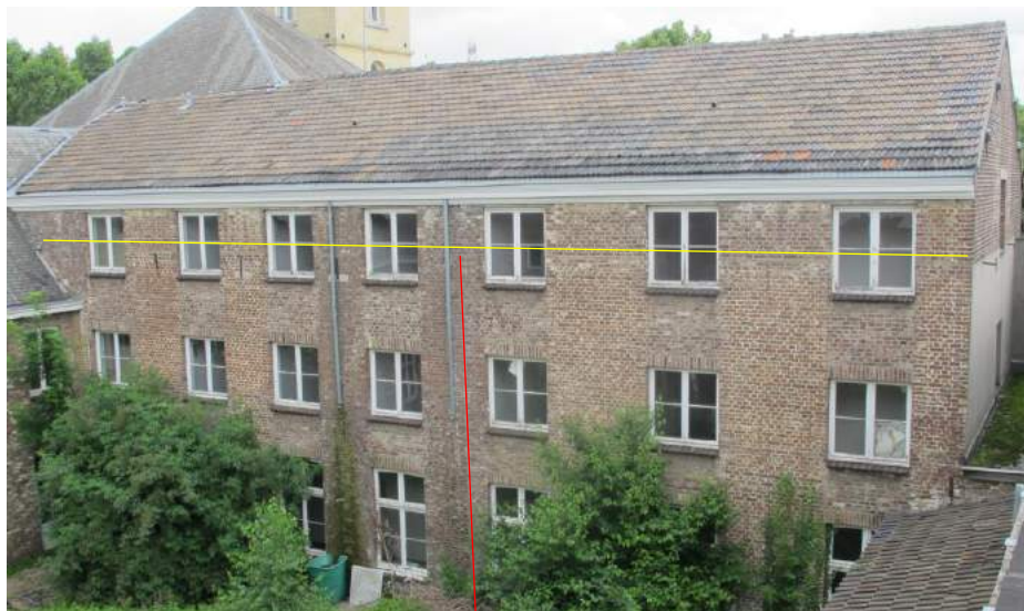
De binnenzijde van de noordvleugel. De rode lijn markeert een bouwnaad. Het deel rechts daarvan is gebouwd in 1880. Boven de gele lijn de ophoging van 1961.
