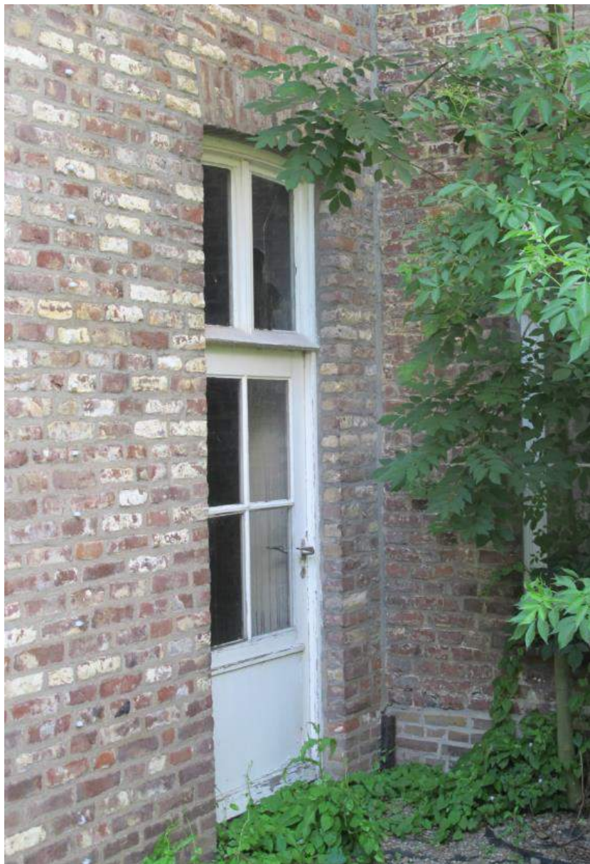
Detail van de entree in de hoek waar de west- en noordvleugel samenkomen.
