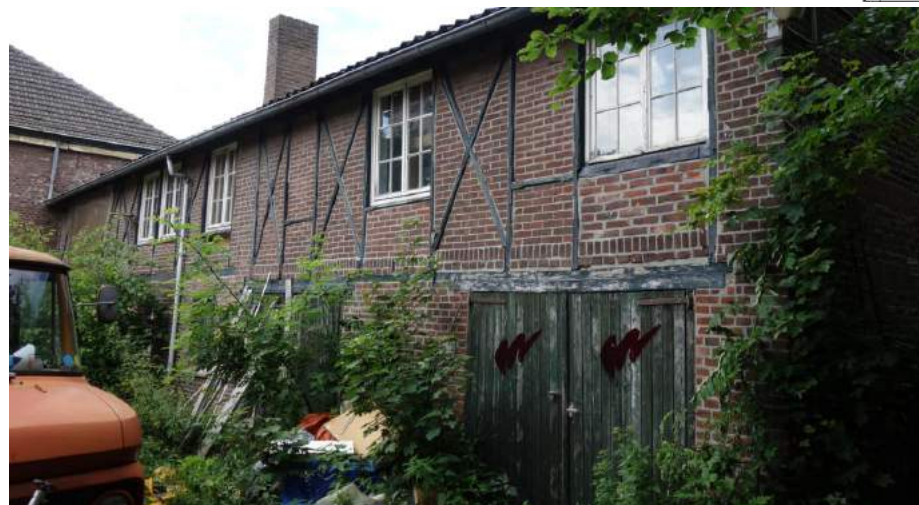
De zuidgevel van de schuur in vakwerk.
