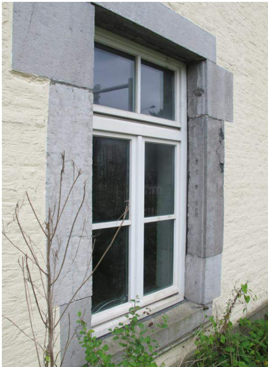
Detail van één van de mogelijk oorspronkelijke vensters, voorzien van een modern raam op de begane grond in de zuidvleugel aan de linkerzijde van het risaliet.
