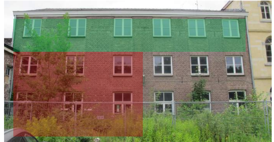
Zicht op de buitenzijde van de noordvleugel met in het rode vlak de dichtzetting uit 1880 en in het groene vlak de ophoging van 1961.
