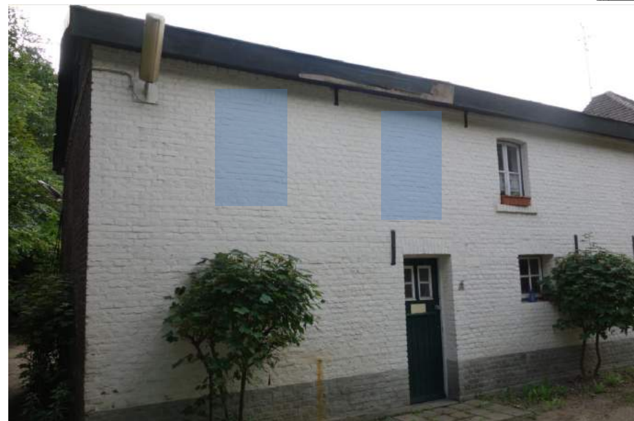
De noordgevel van de uitbreiding van de uitbouw uit 1880 met in het blauw de venster dichtzettingen.
