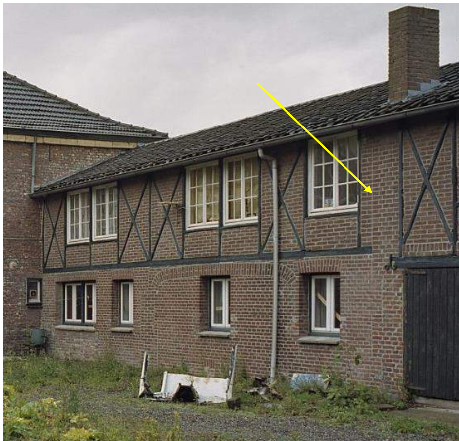
Zicht op de zuidgevel in vakwerk van de boerderij. De gele pijl wijst naar een bouwnaad. Links van de naad de boerderij uit 1866 en rechts de uitbreiding van 1880 of iets later. Le ook op de extreem brede, later weer dichtzette poort onder een sterk uitgerekte korfboog. Foto G. Dukker RCE 2004
