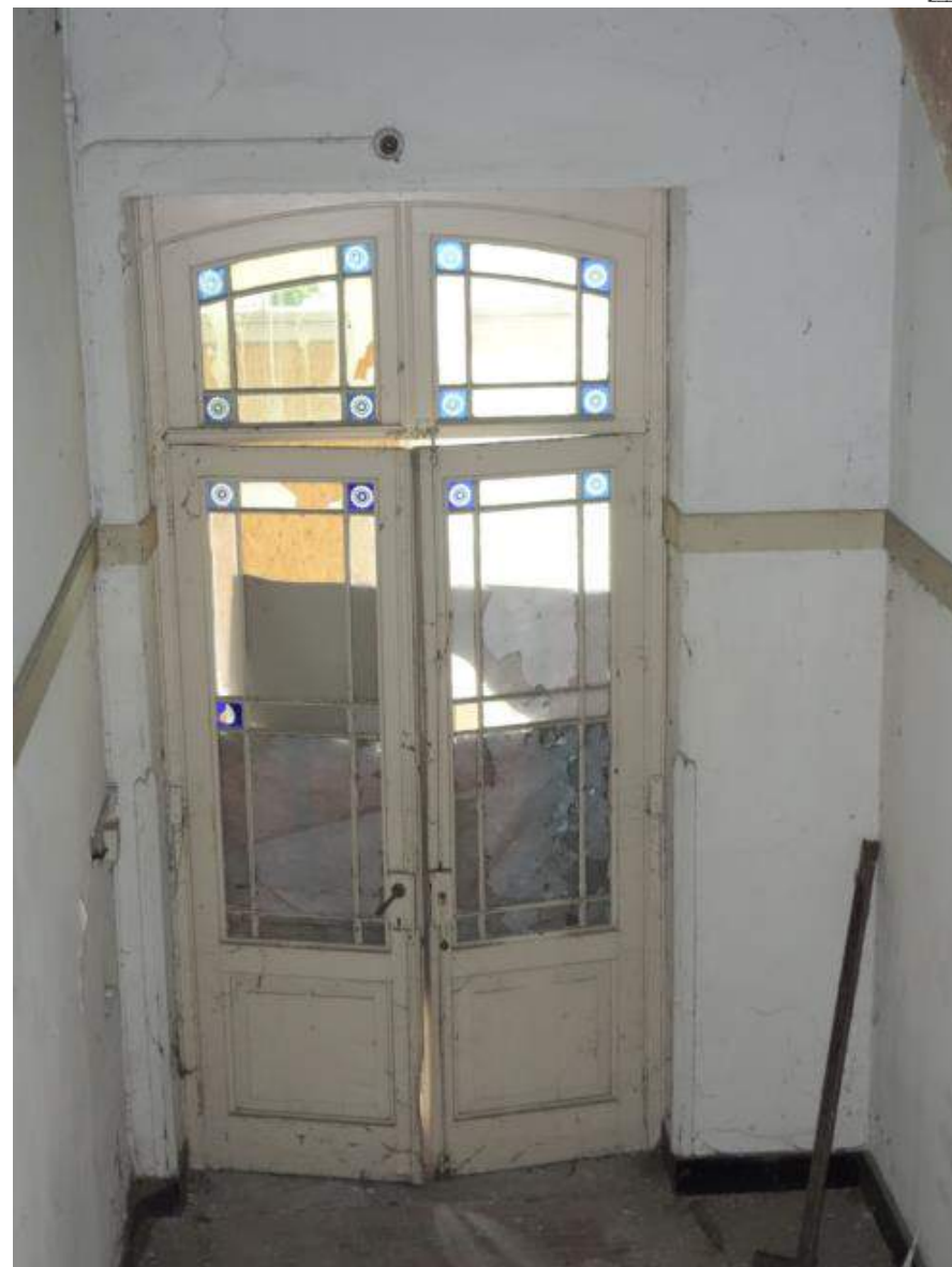
De entree in de oostzijde van de kloostervleugel uit 1880 gezien van binnen uit.
