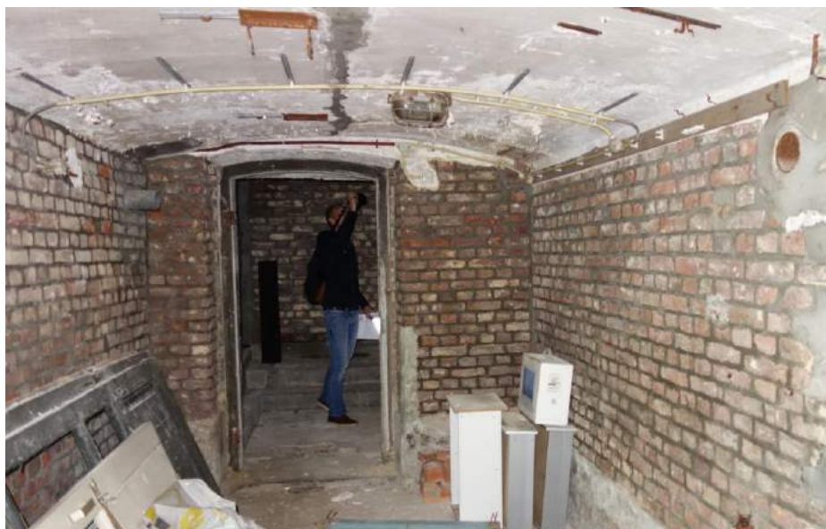
De kelder onder de kloostervleugel uit 1880 gezien richting het oosten.
