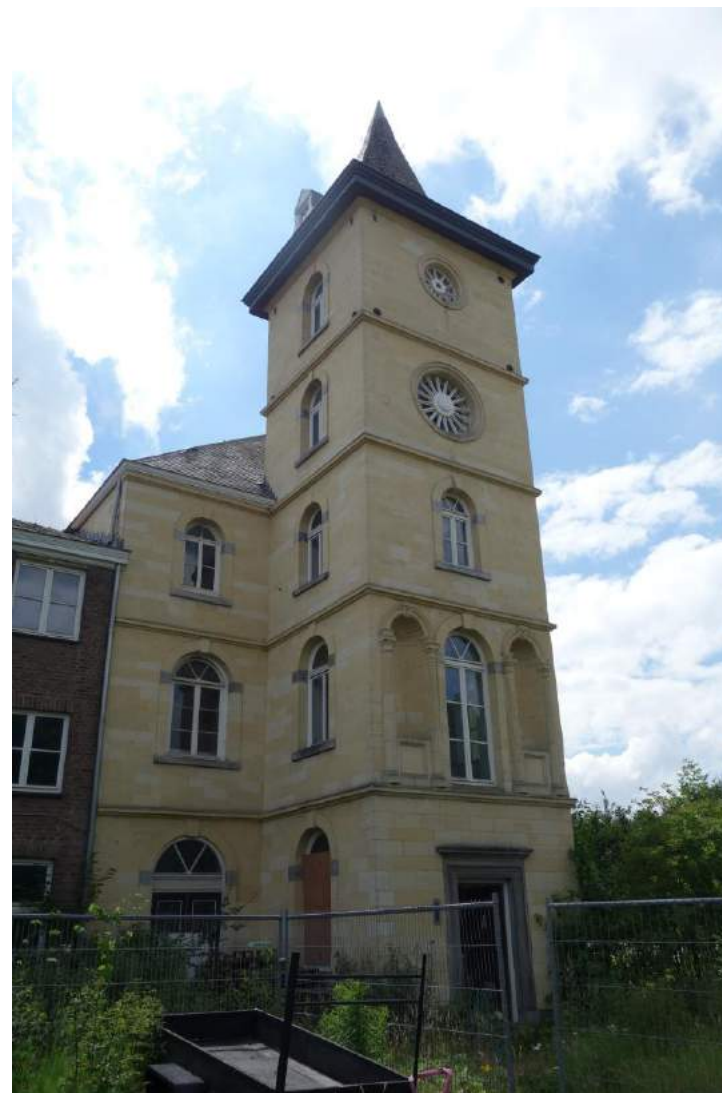
De door Regout in 1866 toegevoegde mergelstenen noordelijke toren met paviljoen. De beeldnissen op de tweede geleding vertonen neorenaissancevormen. De ronde vensters bevatten ijzeren industriële wielen, verwijzend naar Regouts achtergrond.
