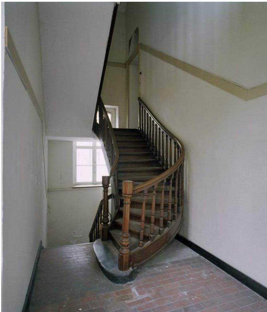
Trappenhuis met fraaie trap uit 1880 in het oostelijke deel van de zuidvleugel, oorspronkelijk een verbindingslid tussen de oudbouw en het in 1880 gebouwde klooster. Thans is deze trap zwaar onttakeld en incompleet. Foto G. Dukker 2004 Beeldbank RCE
