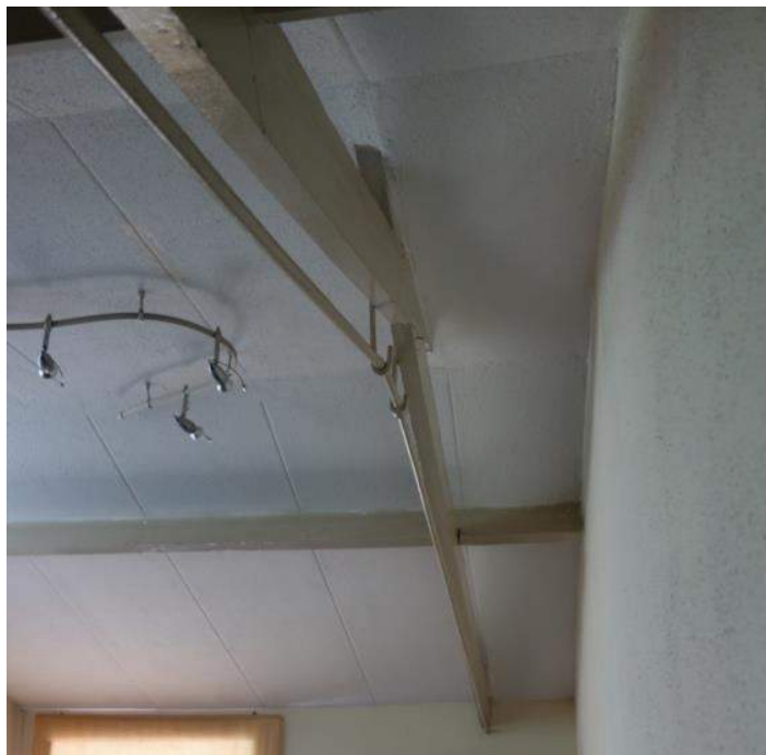
Een van de kaspanten met trekstang in de uitbouw aan de oostzijde van de noordvleugel.
