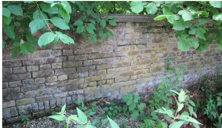
De zuidelijke tuinmuur met betonnen afdekplaat.
