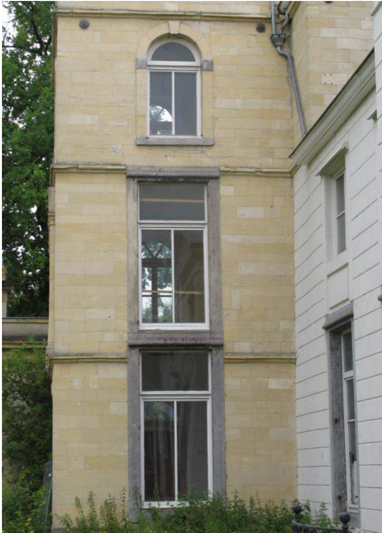
Zicht op de achterzijde van de zuidelijke toren waar de vensters op de begane grond en verdieping een hardstenen omlijsting hebben zoals de vensters op de begane grond van de zuidvleugel.
