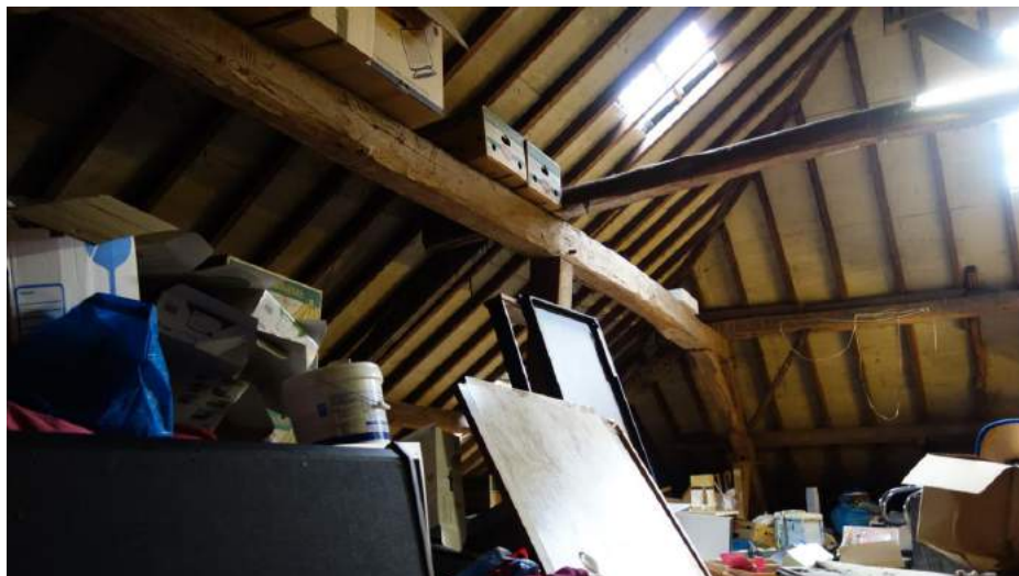
Het noordelijke dekbalkjuk boven het bouwdeel aan de oostzijde van de noordvleugel waar verschillende telmerken op zijn aangebracht.
