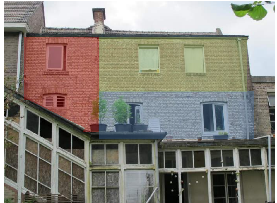
De indeling van oostgevel met het oudste deel (blauwe vlak), een ophoging van vóór 1900 (rode vlak) en een ophoging van na 1900 (groene vlak)
