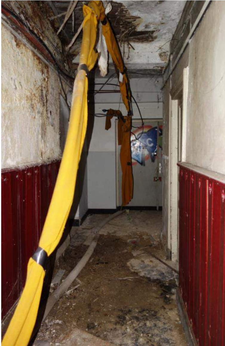
Zicht op de gang aan die de oostvleugel verbind met de zuidvleugel gezien richting het oosten. Aan het einde van de gang is de entree naar de gymzaal.
