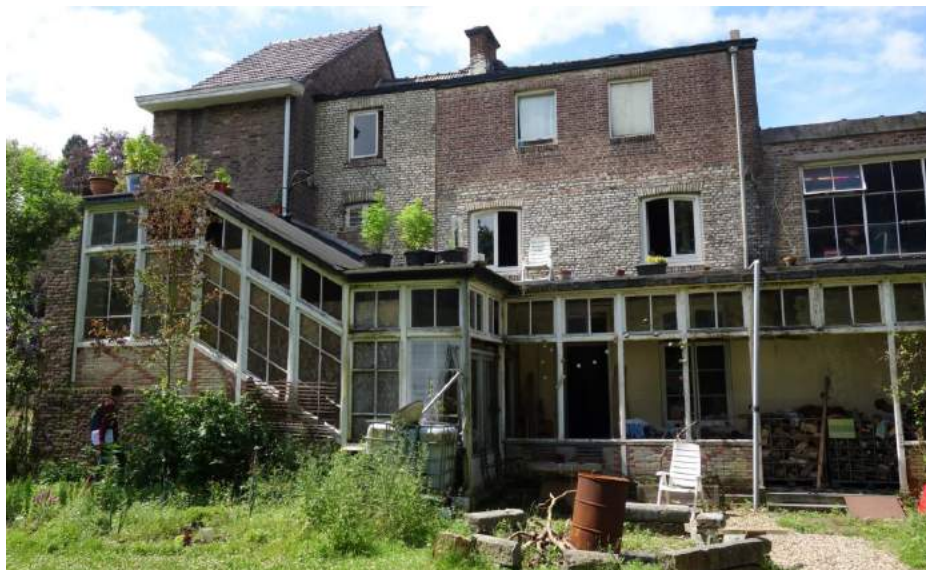
De oostvleugel gezien richting het westen met zichtbaar de verschillende bouwfasen in het muurwerk.
