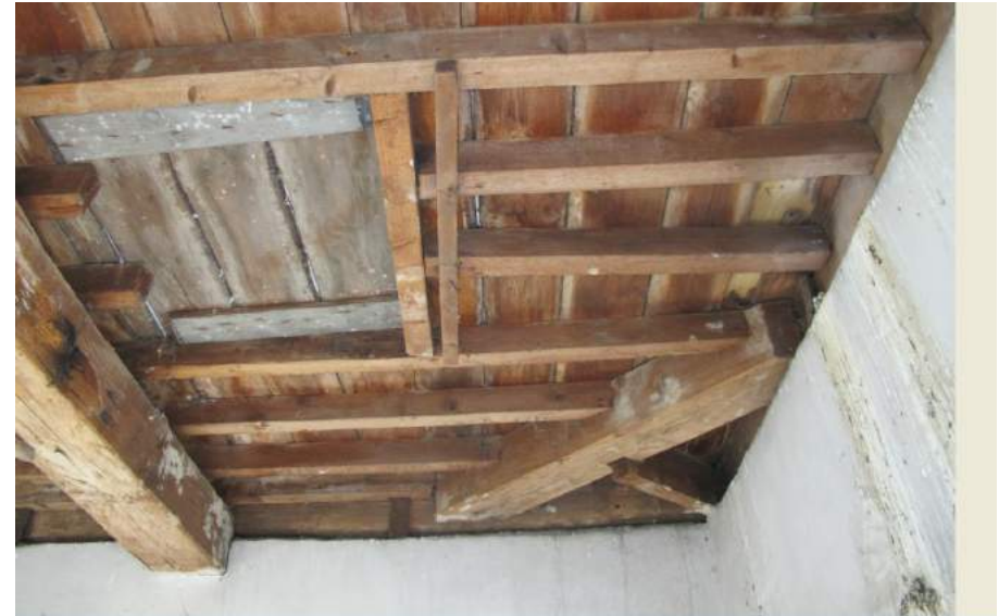
De samengestelde balklaag boven de bovenste verdieping van de zuidelijke toren. Het luik geeft toegang tot de torenkap.
