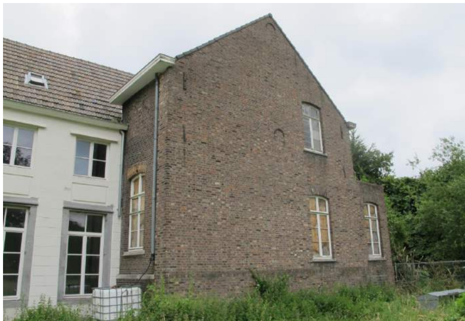
De topgevel van de kloostervleugel gezien richting het noordoosten.
