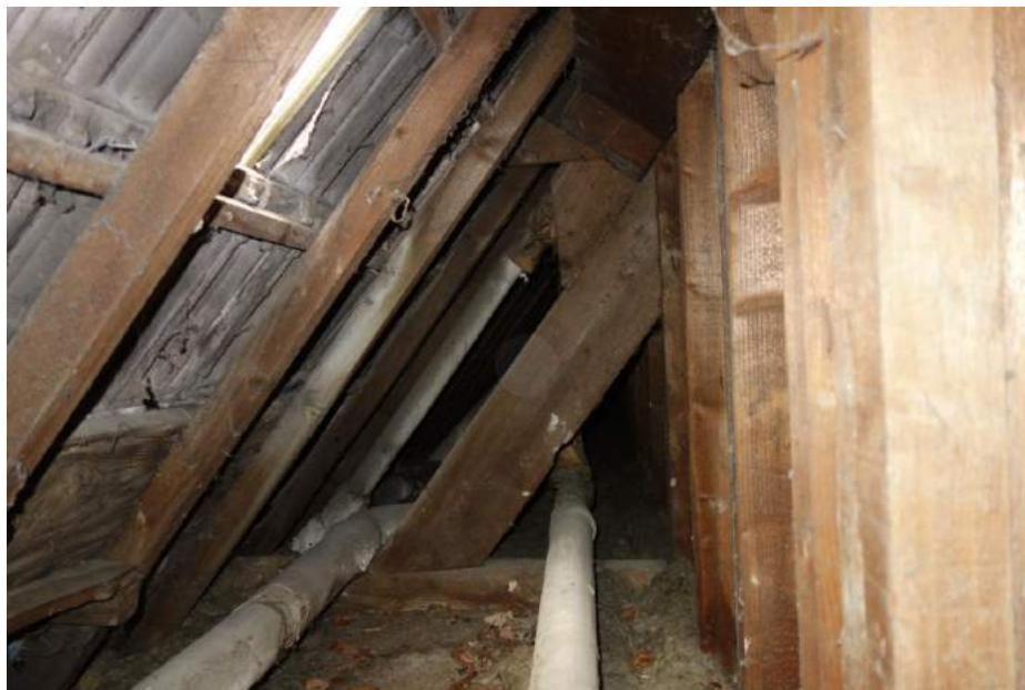
Een van de spantbenen van het Hollandse spant boven de zuidvleugel.
