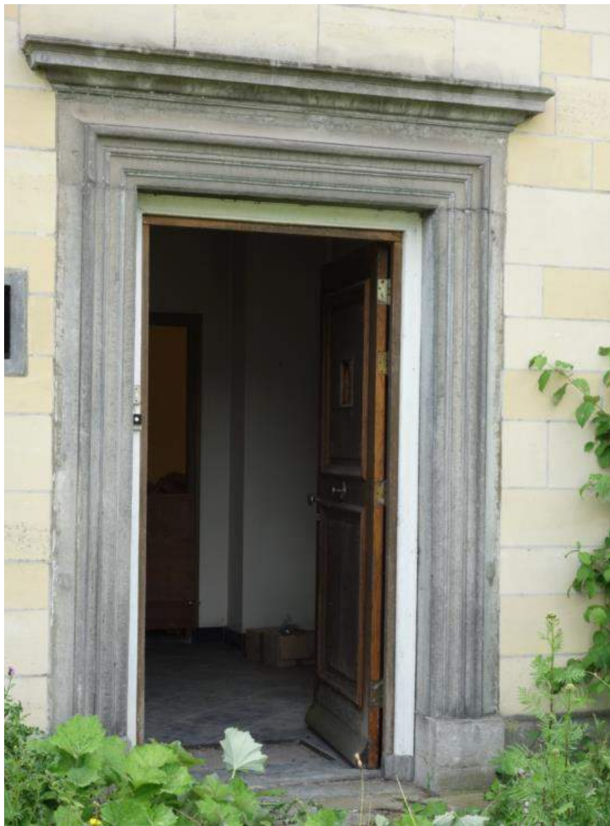
Detail van de entree aan de noordzijde van de noordelijke toren.
