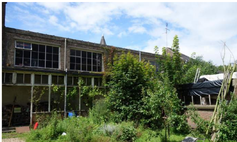
De gymzaal aan de oostzijde van het complex gezien richting het noordwesten.
