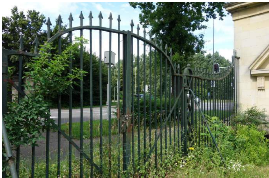
Het vermoedelijk 19de -eeuwse hekwerk tussen de portgebouwen.
