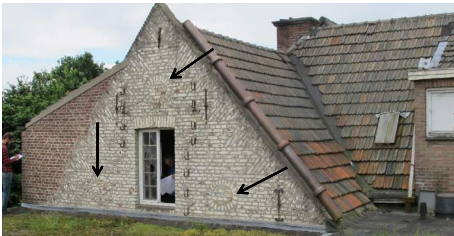
Detail van de topgevel van het tussengedeelte uit de 18de eeuw met bij de pijlen oeil-de-boeufs.
