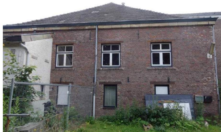
Noordgevel van het bouwdeel (boerderij) aan de oostzijde van de noordvleugel.
