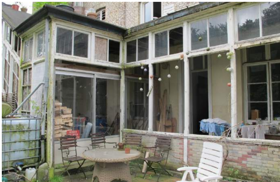
De veranda uit 1880 aan de oostzijde van het complex gezien richting het zuidwesten.
