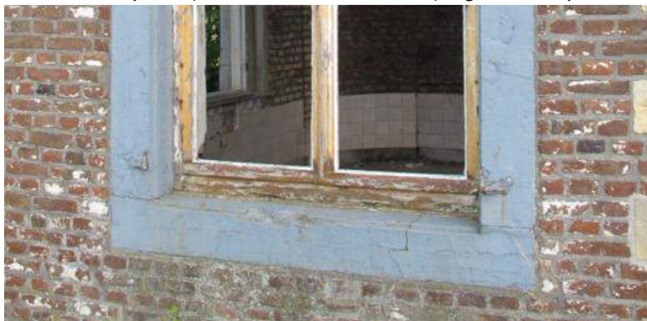
Detail van een niet oorspronkelijke vensteromlijsting bij het westelijke paviljoen.
