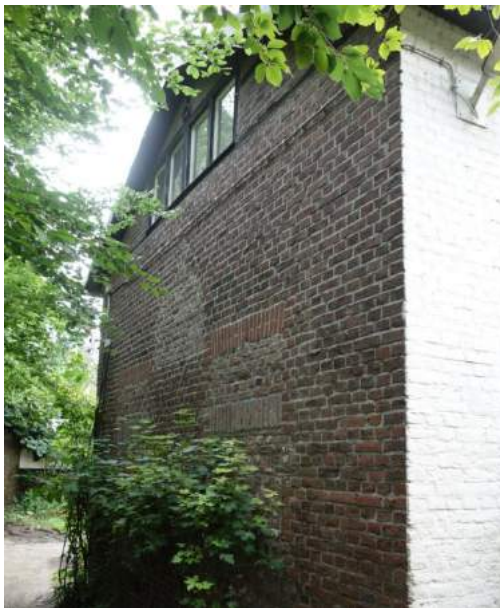
De topgevel van de uitbouw uit 1880 met dubbele dichtzettingen van twee vensters en een rondboogvenster op de begane grond en een vier-ruits venster tussen regelwerk op de verdieping.
