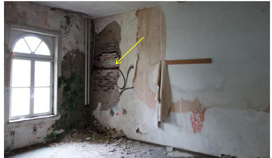
Zicht op de oude binnenmuur tussen de grote zaal en de aanbouw van de hoektoren op de begane grond in de westvleugel. Bij de gele pijl is het oude kozijn zichtbaar dat hoort bij de enfilade opzet van de ruimte.
