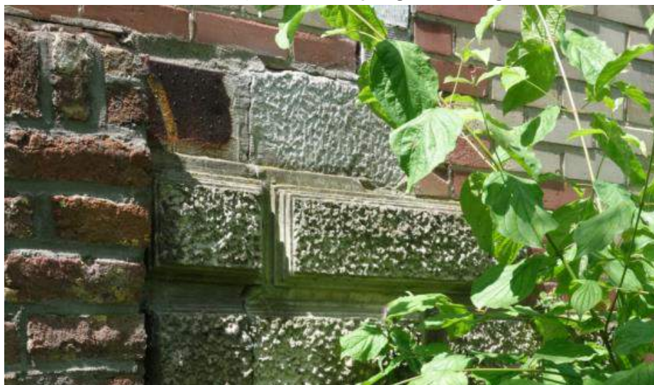
Detail van het stucwerk onder trap bij de veranda uit 1880.
