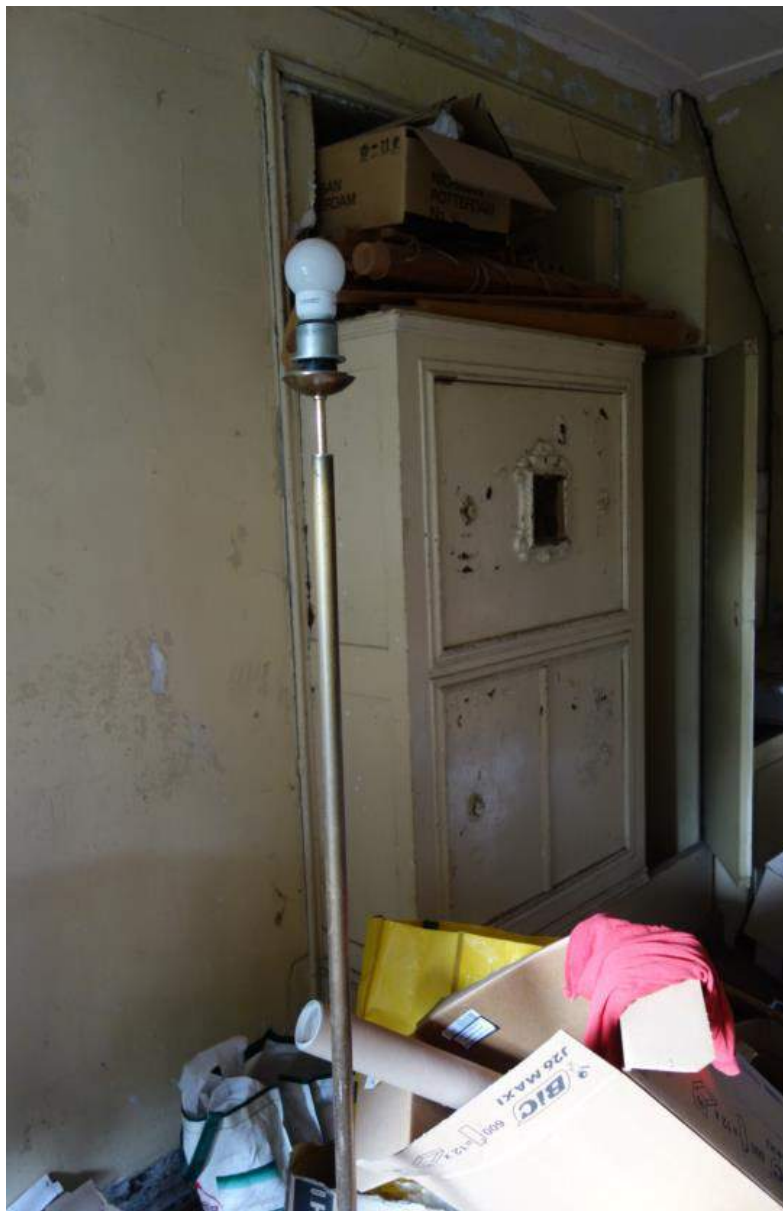
Detail van de kluis op de tweede verdieping aan de oostzijde van het complex.
