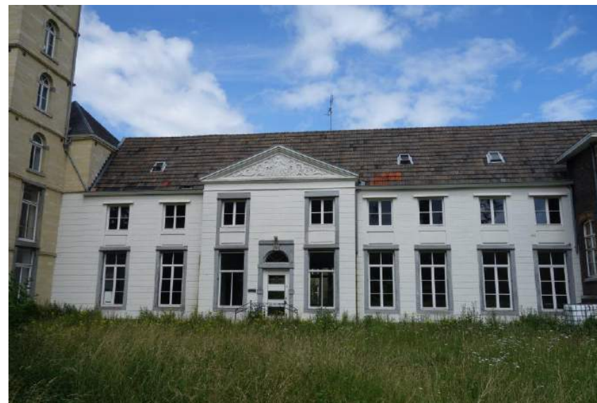
Zicht op de gevel van de zuidvleugel die in kern nog dateert uit de periode 1730-36.
