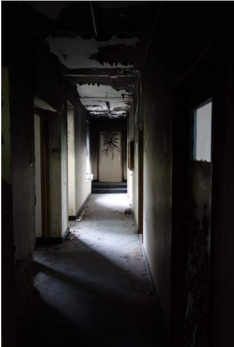
De gang op de begane grond aan de noordzijde van de westvleugel gezien richting het zuiden.
