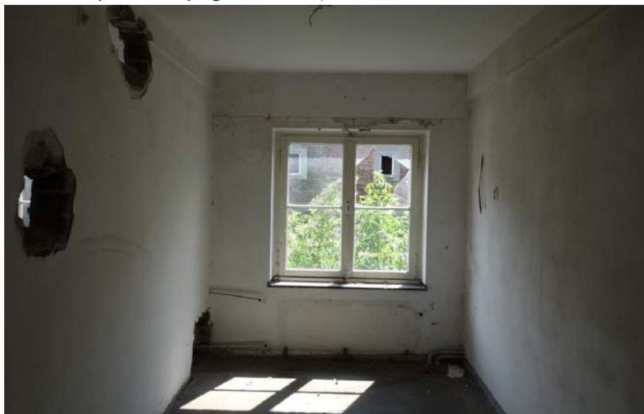
Een van de ruimten op de verdieping van de noordvleugel.
