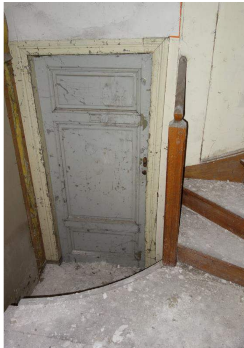
Een van de oude paneeldeuren met geprofileerd kozijn op de verdieping aan de oostzijde van het complex.
