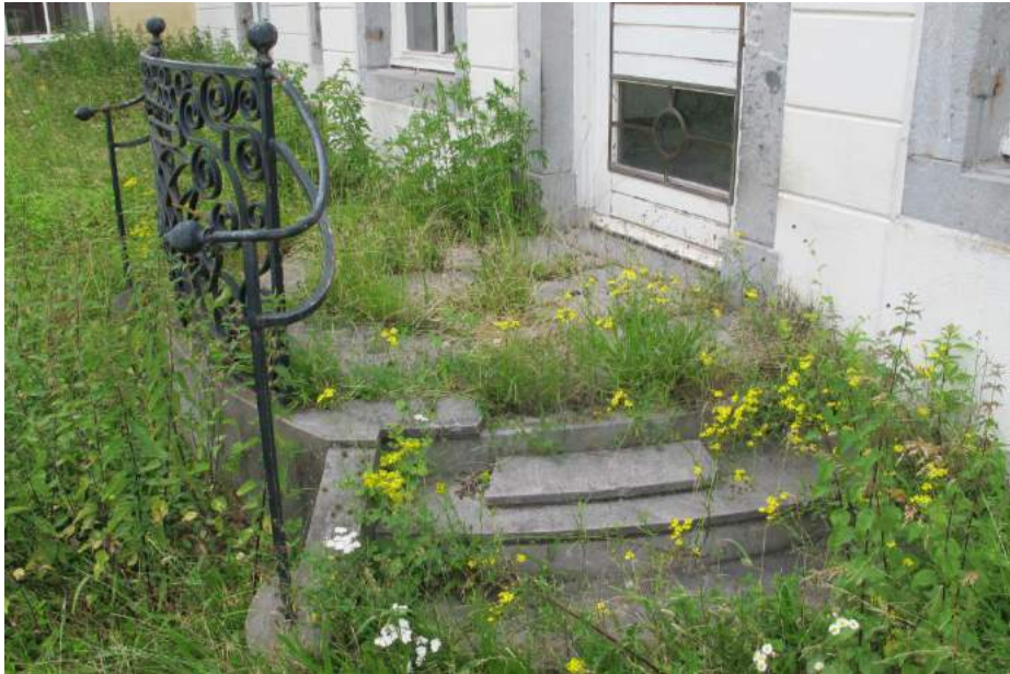
Detail van de moderne lage bordestrap met hekwerk.
