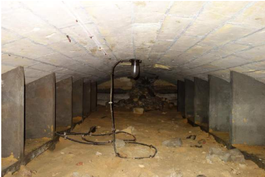
Zicht in de noordelijke kelder van de naast elkaar gelegen kelders in de westvleugel.
