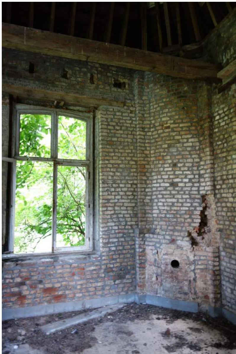
Zicht in het vrijwel volledig kaal gemaakte interieur van het oostelijke paviljoen.
