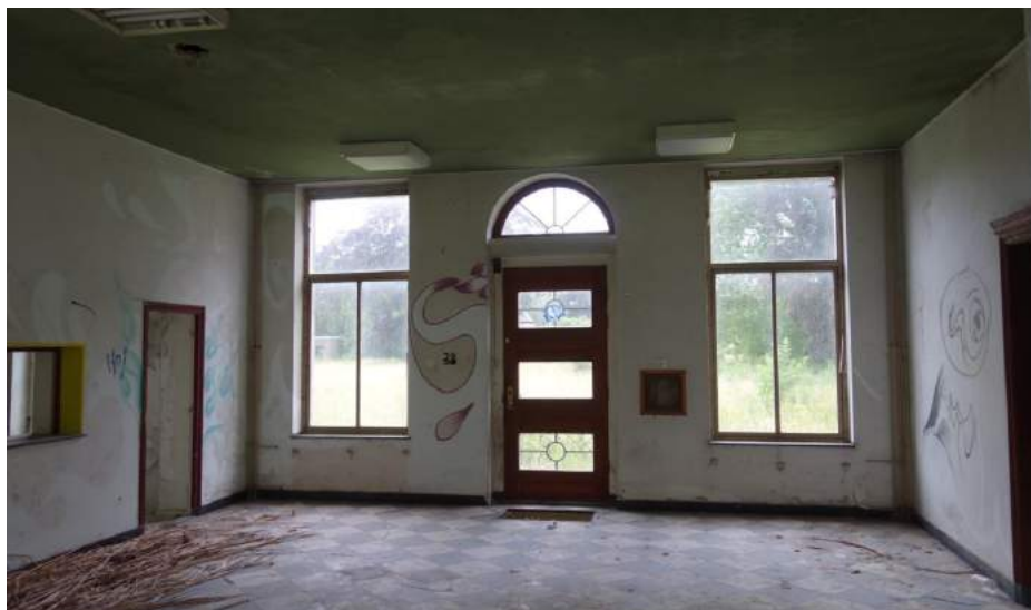
Zicht op de ontvangstruimte achter de entree in de zuidvleugel gezien richting het zuiden.
