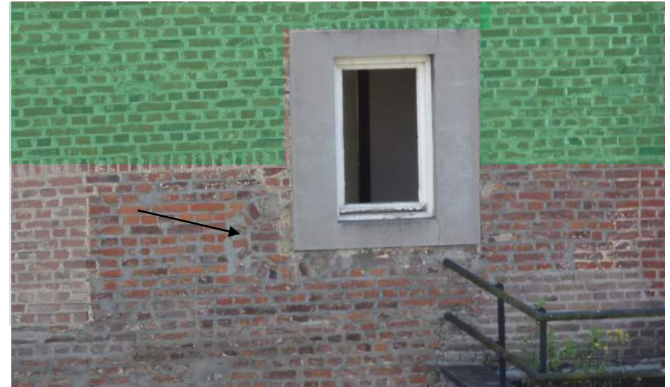
Detail van de binnenzijde van de zuidvleugel met een 18de -eeuwse oeil-de-boeuf (zwarte pijl) en een eerdere ophoging van de gevel in 1948. (groene vlak).
