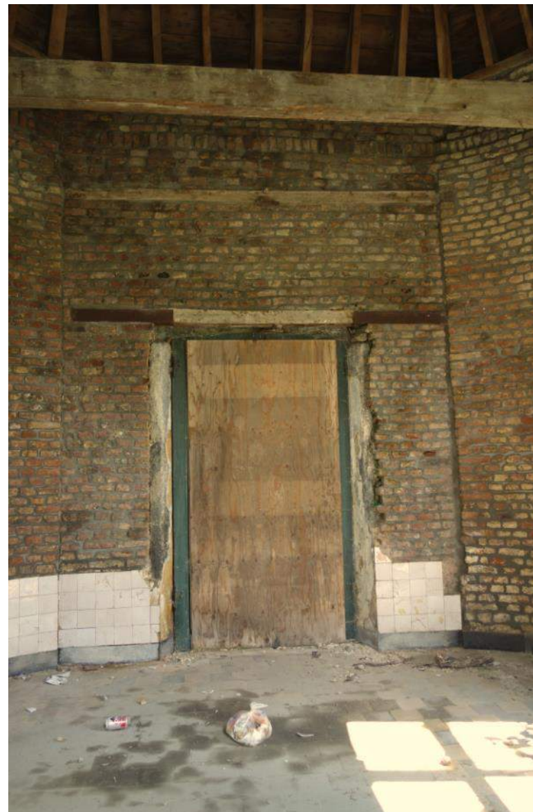
Het vrijwel volledig kaal gemaakte interieur van het westelijke paviljoen richting oosten.
