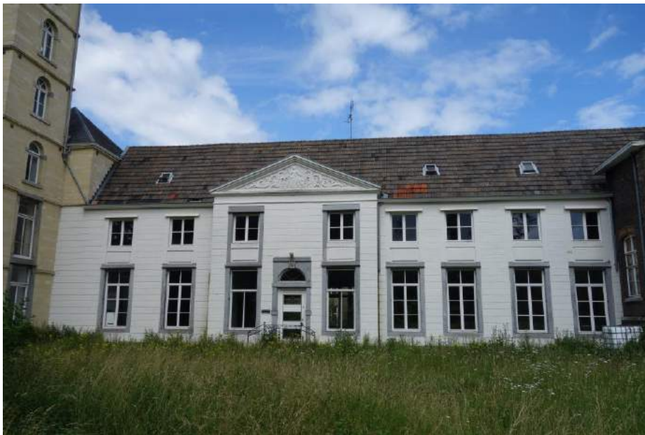
Overzicht van de zuidgevel van de zuidvleugel.
