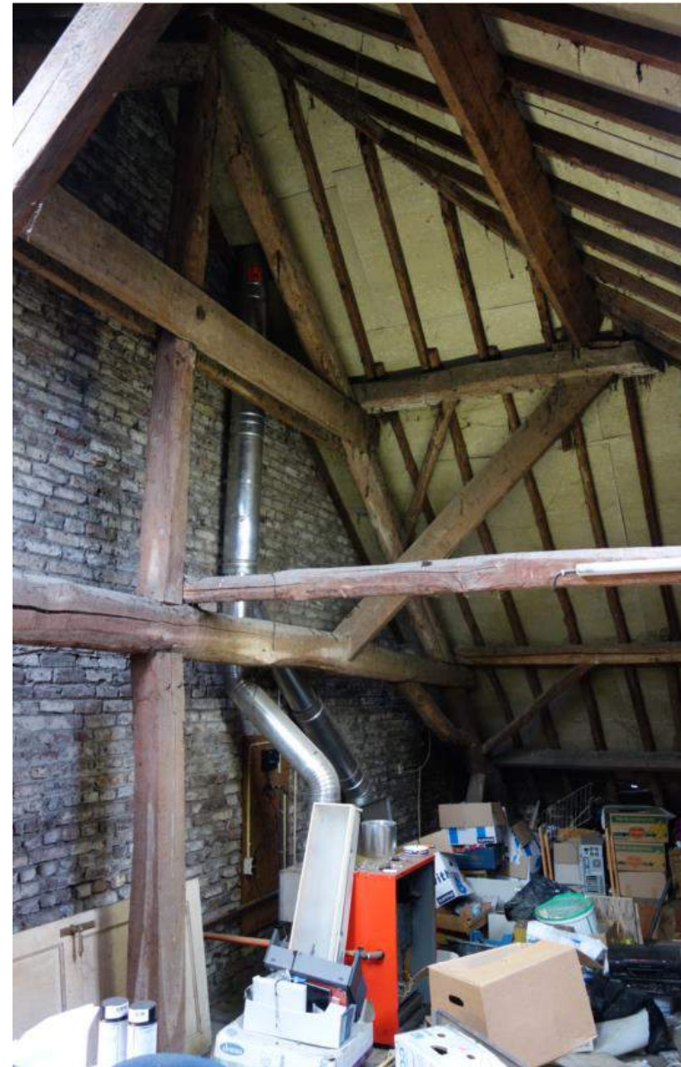
Gestapeld dekbalkjuk met A-spant en middenstijl boven het bouwdeel aan de oostzijde van de noordvleugel.
