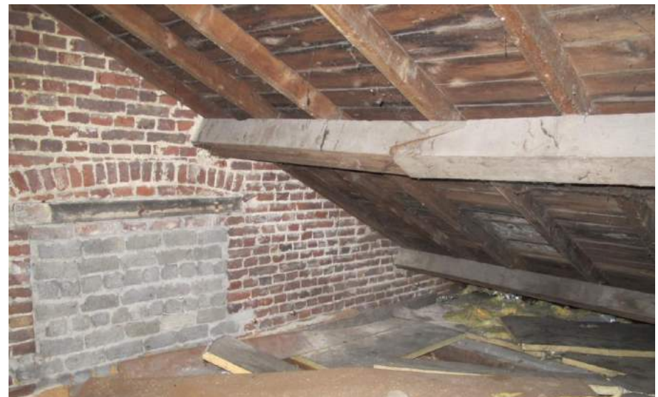
Gordingkap boven de noordvleugel gezien richting het oosten.
