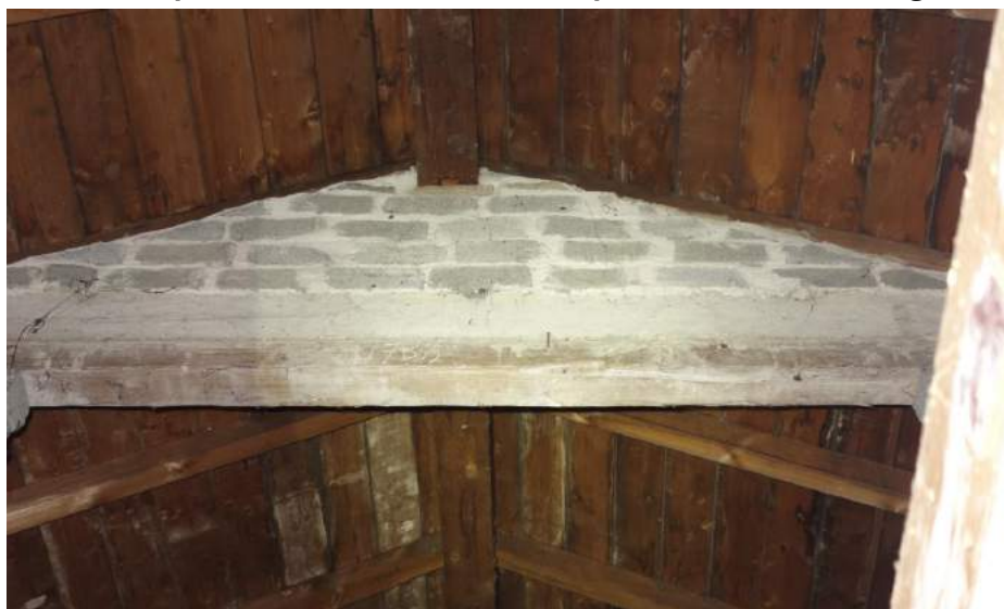
De kapconstructie boven de westvleugel.
