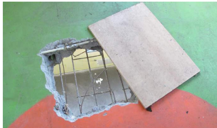
De verdiepingsvloer van holle betonstenen in de westvleugel.
