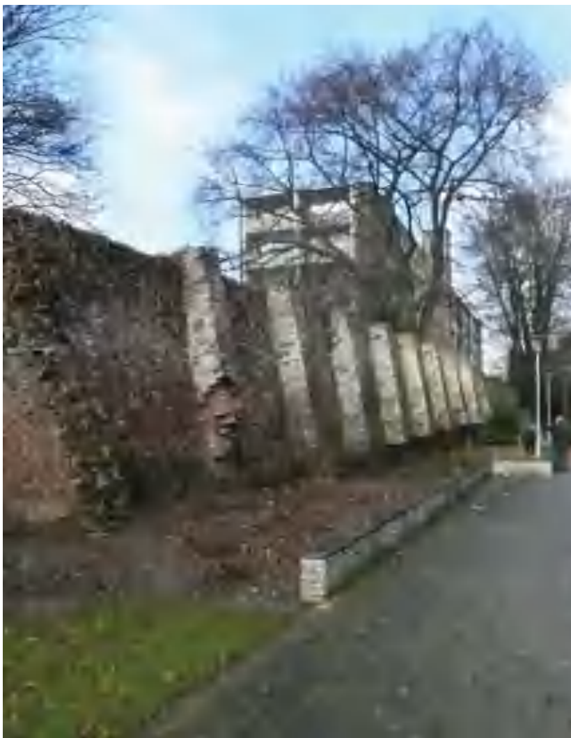
Schoormuur gezien vanuit het zuidoosten, foto 2009
