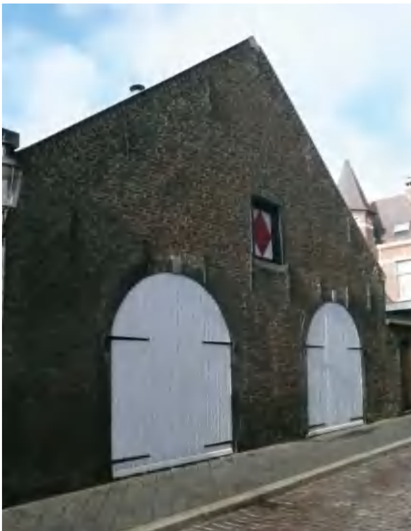
Abtstraat 4: zijgevel van de affuitloods
