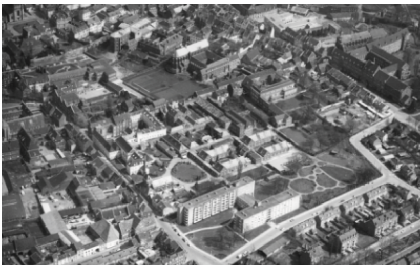
Luchtfoto van het Klevarieterrein vanuit het westen in 1961
