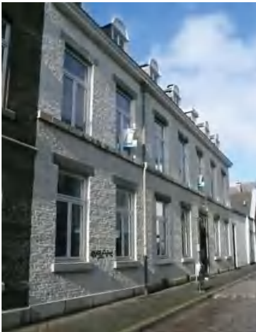
Abtstraat 4: Monumentaal woonhuis naast de affuitloods
