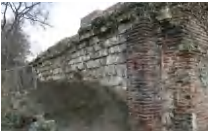
Schoormuur gezien vanuit het zuidwesten, foto 2009
