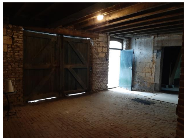
Foto 10. Voormalige stallen zuidvleugel
