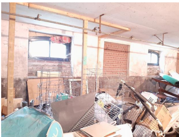
Foto 9. Voormalige stallen zuidvleugel
