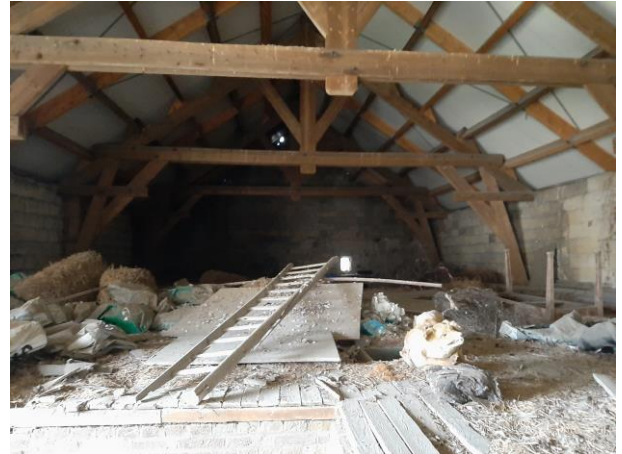
Foto 8. Verdieping boven voormalige stallen zuidvleugel
