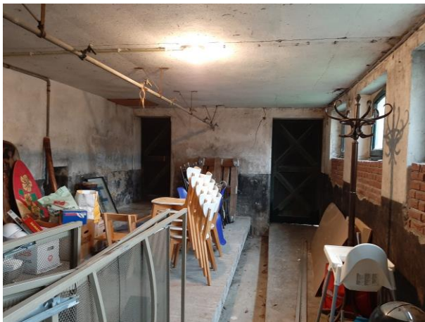
Foto 11. Voormalige stallen zuidvleugel
