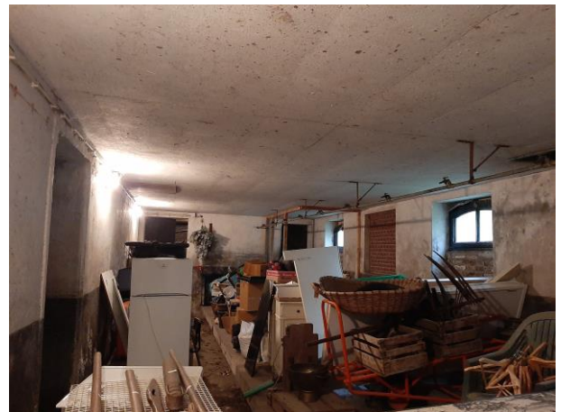
Foto 12. Voormalige stallen zuidvleugel
