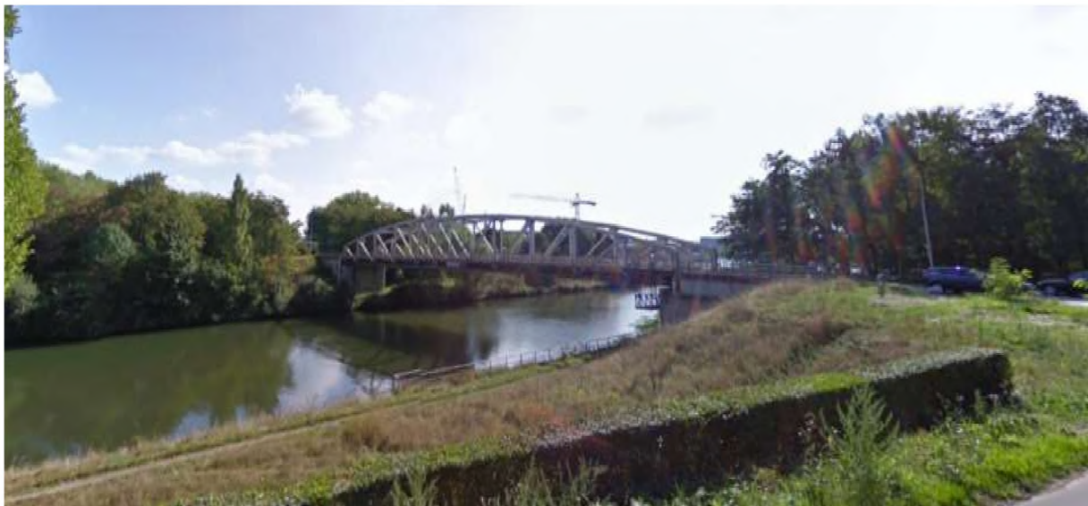
Figuur 24: Impressie van de huidige brug over het Julianakanaal ter plaatse van het plangebied. 36 Boven een zicht in westelijke richting en onder een zicht in zuidelijke richting.
