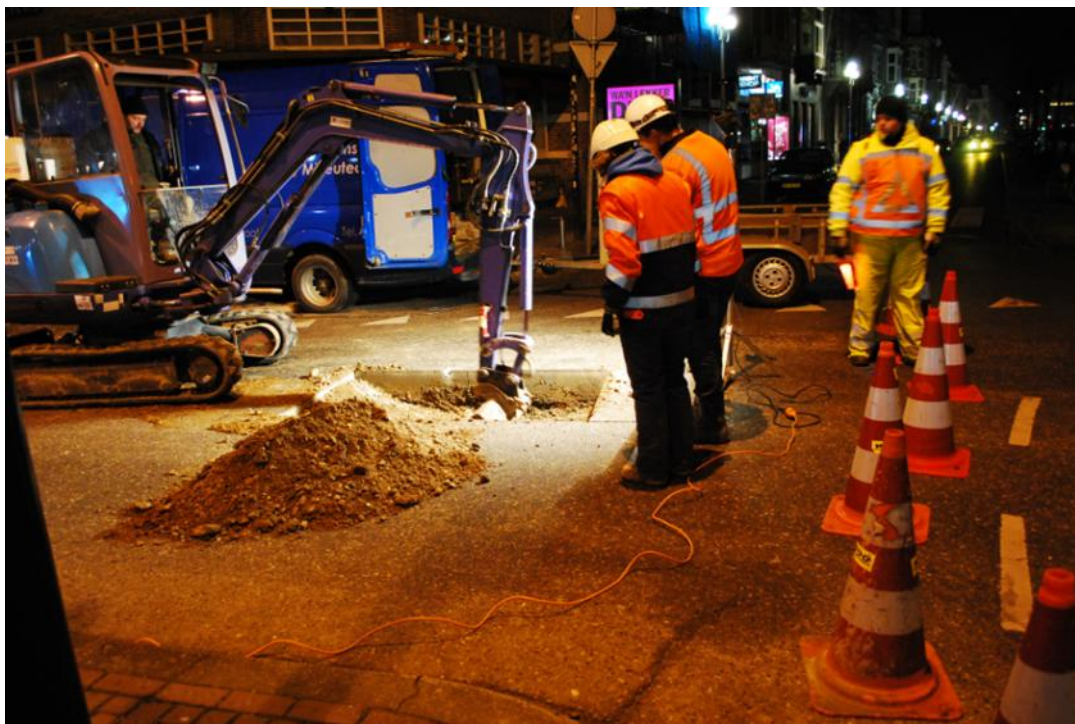
Afbeelding 12. Aanleg put 5 waarvoor eerst een 25 cm dikke asfaltlaag verwijderd moest worden.
