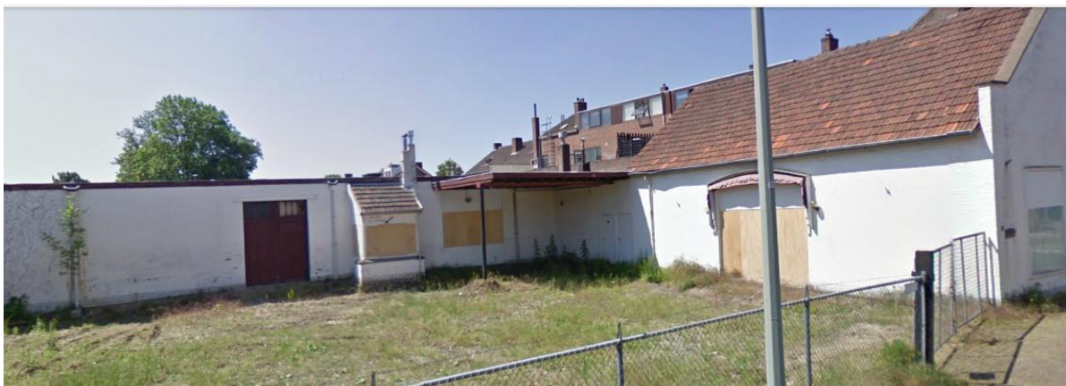
Afb. 2 Weergave van de bestaande bebouwing in het plangebied. De bebouwing zal geheel worden gesloopt.
