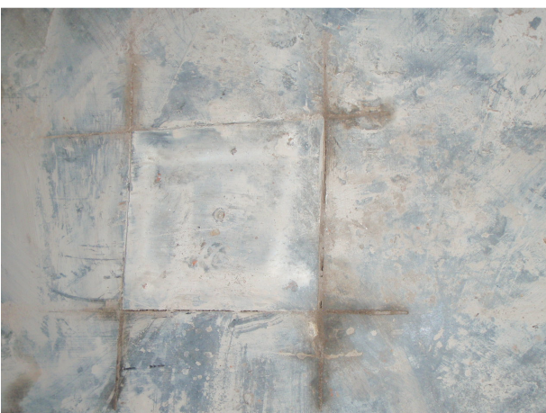
Foto 5: Er zijn ook binnen onder het beton gaten ge-Graven voor funderings- en asbestonderzoek.
