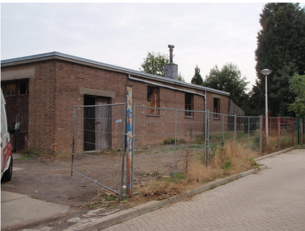
Foto 3: Achterzijde van het pand aan de toegangsweg naar Demerthof, fase 1.
