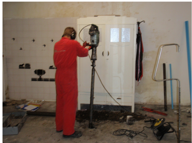
Foto 4: Plaatsing peilbuis 1 met ramspits en verloren-punt methode .
