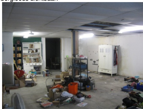
Foto 6. Impressie van de binnenzijde van de voormalige woning(?).
