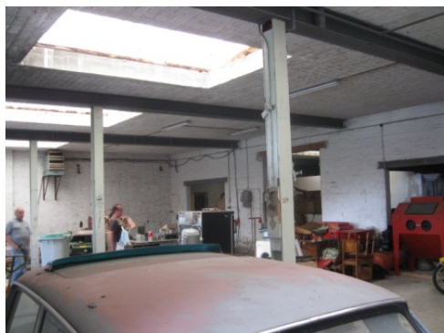
Foto 5. Impressie van de binnenzijde van de voormalige bedrijfsgebouwen.
