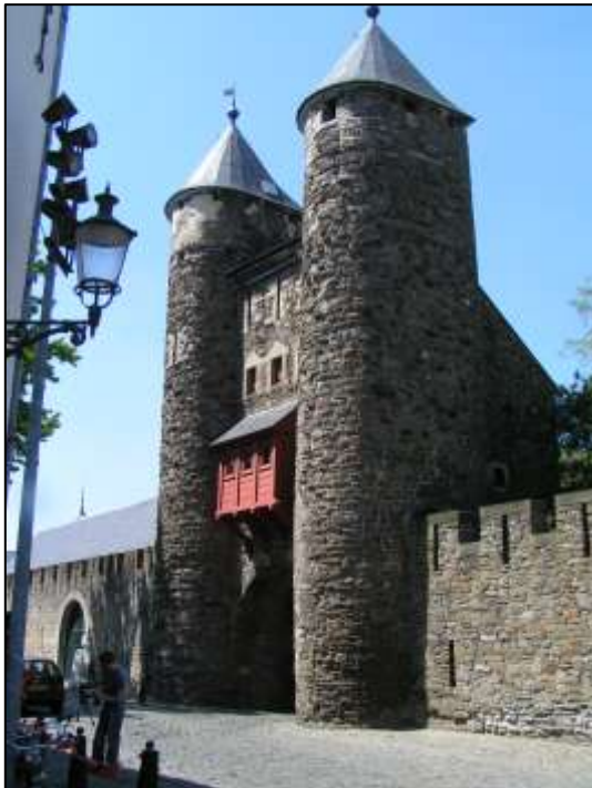
Figuur 17: recente foto van de Helpoort, die behoorde bij de eerste middeleeuwse stadsomwalling uit de 13e eeuw.
