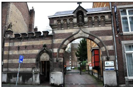
Poortgebouw aan de Brusselsestraat
