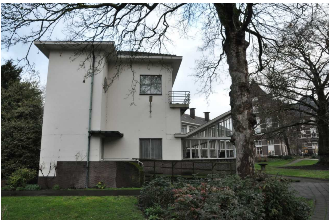
129 Het Lydwina paviljoen, de westelijke kopgevel.
