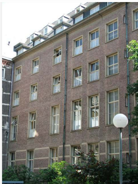
Noordgevel van de zuidelijke vleugel
