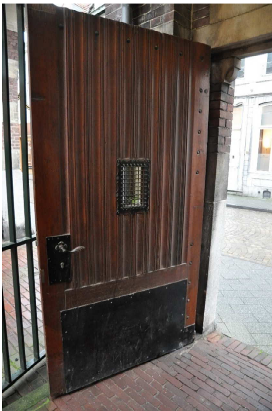
122 Oorspronkelijke personendeur aan de straat.
