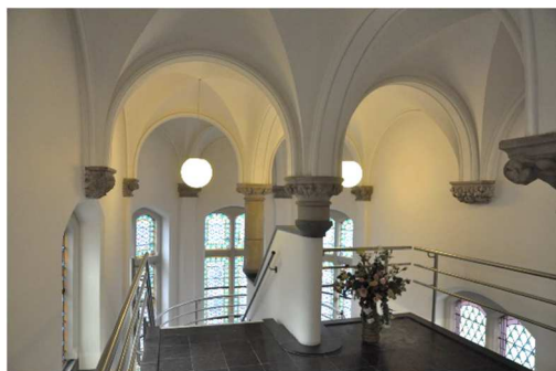
104 De beëindiging van het trappenhuis van de middenvleugel met kruisribgewelven. De trap zelf is vernieuwd in de late twintigste eeuw.
