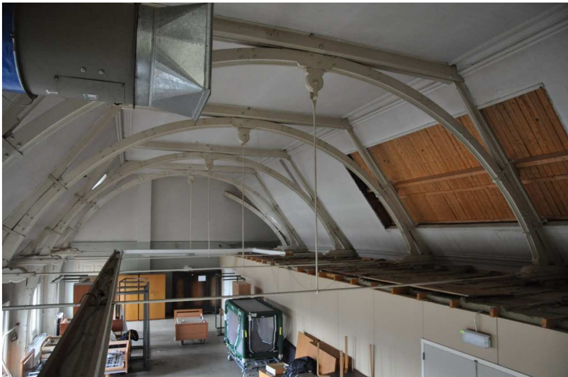
107 De zolderverdieping van de oostvleugel met zicht op de kappanten, gezien naar het zuiden. Rechts de inbouw van een latere gang op dit niveau, met platte afdekking.
