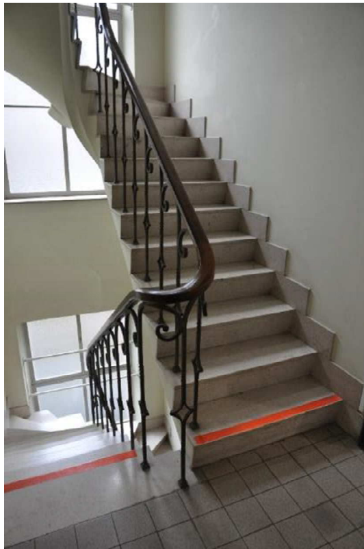
112 Trappenhuis Boostenvleugel aan de westzijde.
