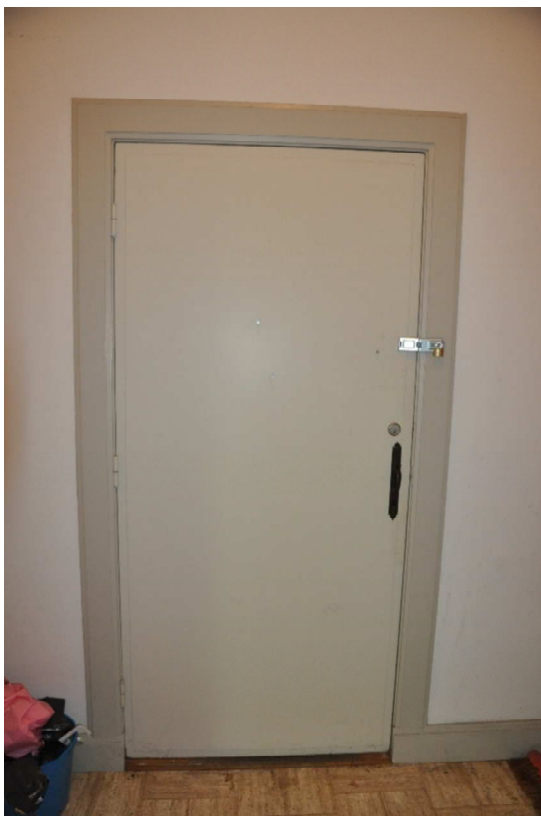
124 Eén van de vernieuwde binnendeuren.
