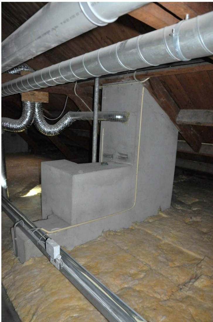
163 Oude ventilatieschacht met later aangebrachte metalen ventilatiekanalen.
