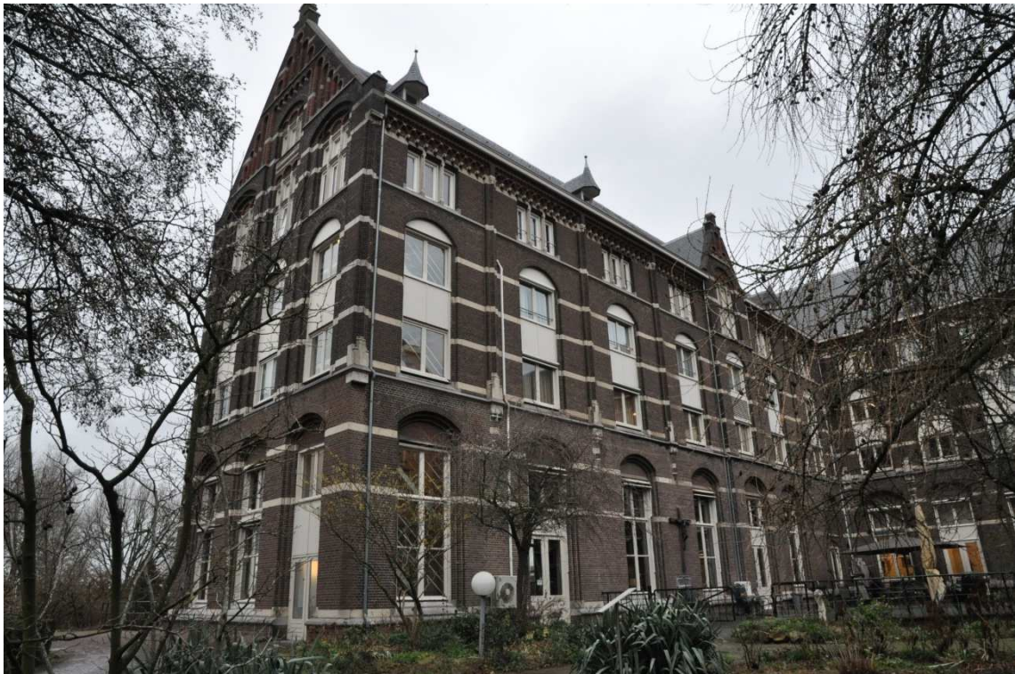
53 Noordelijke vleugel, de zuidgevel en kopgevel.
