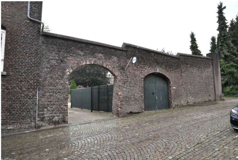
180 De poorten aan Hoogfrankrijk: de poortopeningen zijn niet oorspronkelijk.
