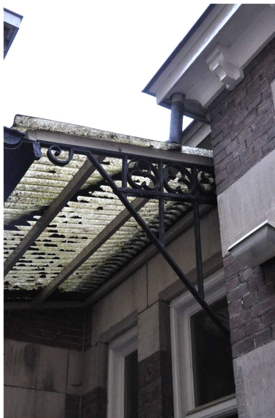
123 Afdak met oorspronkelijke consoles achter de personentoegang van de poortmuur.
