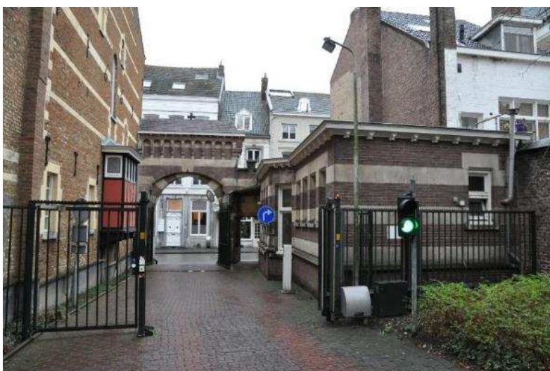
121 Het poortgebouw vanaf het kloosterterrein gezien.
