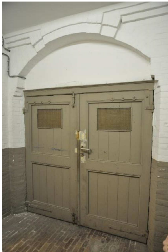
74 Eén van de dubbele opgeklampte deuren uit 1894.
