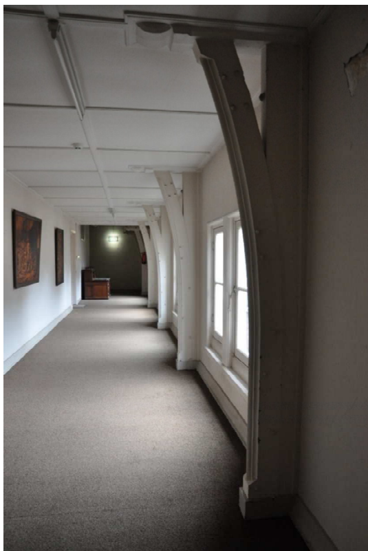
100 Tweede verdieping, gang oude zuidvleugel, met rechts de spantbenen van de kaspanten.
