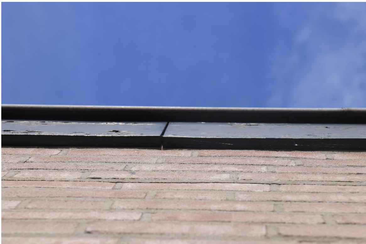
Foto 2: Er zijn nergens geschikte openingen aanwezig in de bebouwing die door vleermuizen gebruik kunnen worden. De daklijsten zitten te strak langs de muren zodat er nergens geschikte openingen aanwezig zijn.
