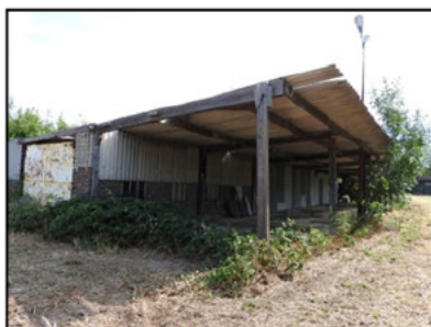
Figuur 10. Aanzicht opstal 6, kijkrichting noordoost.
