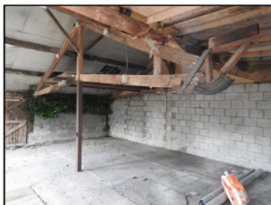
Figuur 6. Binnen aanzicht opstal 2, kijkrichting noord.
