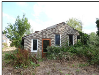
Figuur 4. Vooraanzicht opstal 2, kijkrichting noord.
