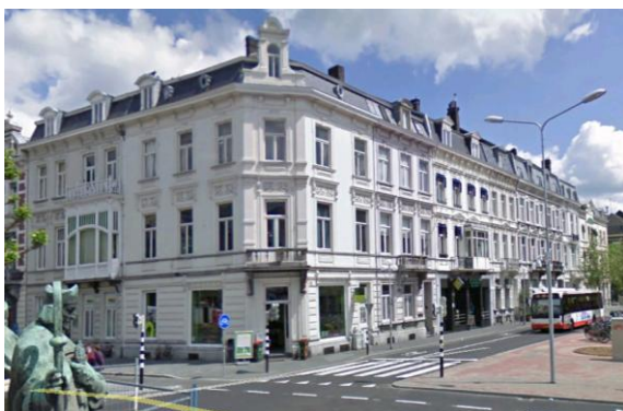
Stationsstraat: drie bouwlagen, hoekafsnijdingen
