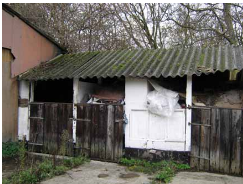
Foto 3: Schuur met golfplaten dak en vloer met asbestverharding
