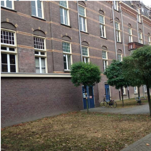
Zijkant oostelijke vleugel hoofdgebouw
