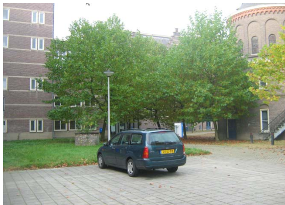
Kapel en naoorlogse aanbouw
