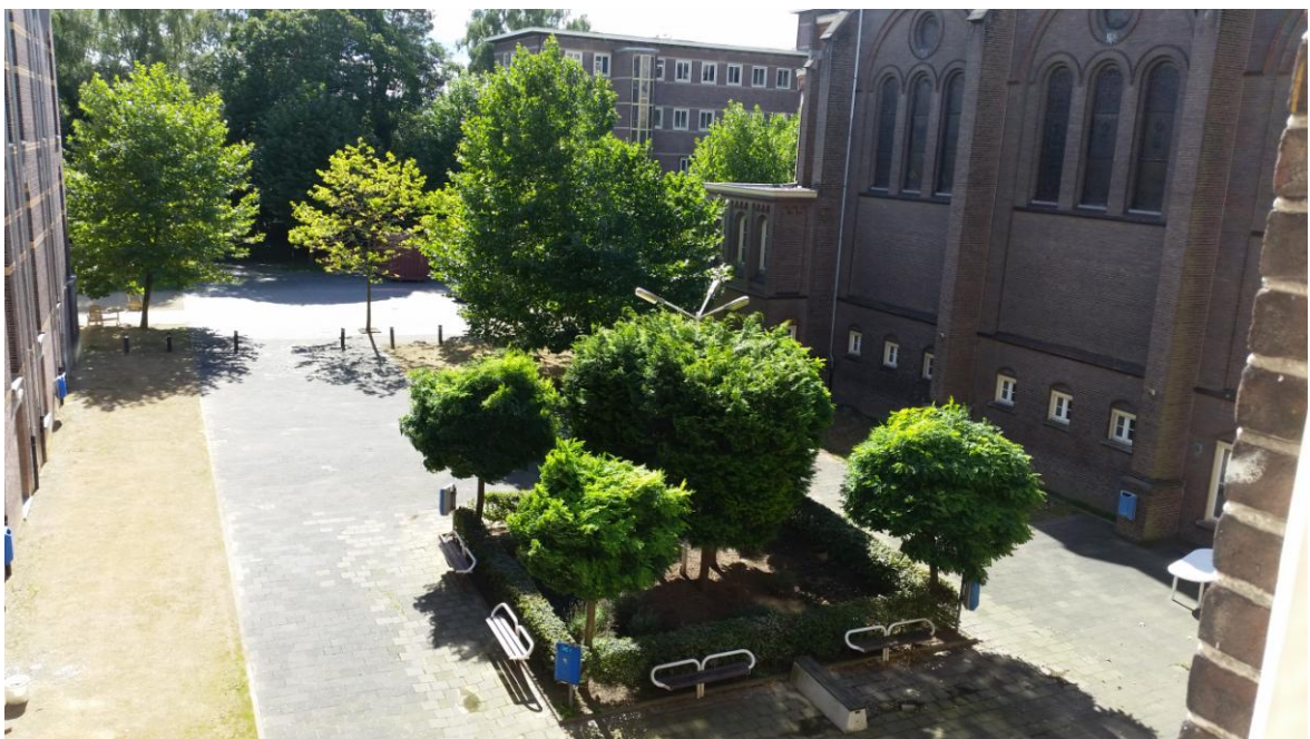
achterzijde gebouw (nr.11 t/m 117)
