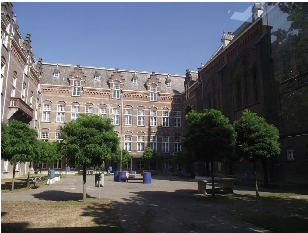
Figuur 3. Een deel van de zuidzijde van het Bonnefantencollege.
