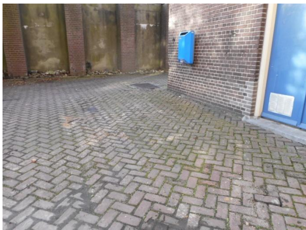
Foto 1: Locatie ondergrondse tank (noordwest)
