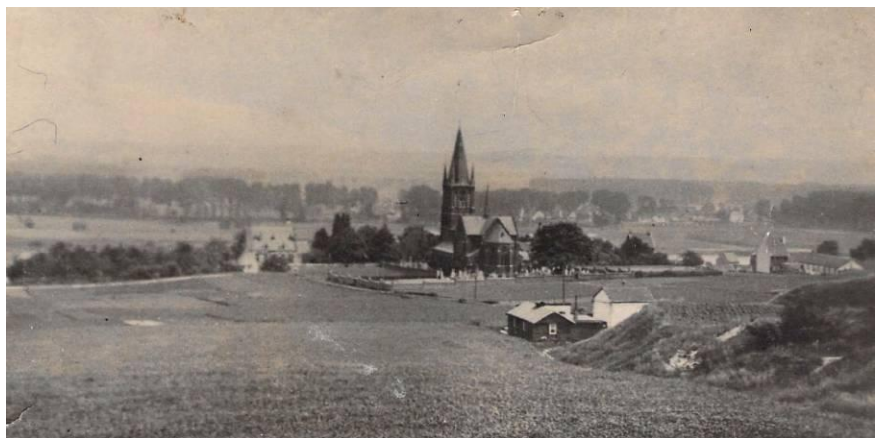
Figuur 2 Foto met stenen schuur
