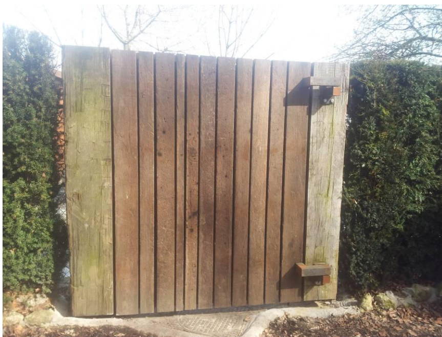
Figuur 9 Huidige toegang, uitgevoerd in Azobéhout (foto Pouderoyen Compagnons)
