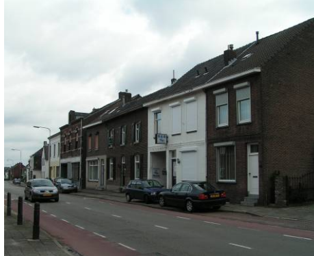
Ambyerstraat Noord (tussen Lindenplein en Severenplein). De gebouwen zijn schouder aan schouder gebouwd, waardoor een gesloten gevelwand ontstaat.
