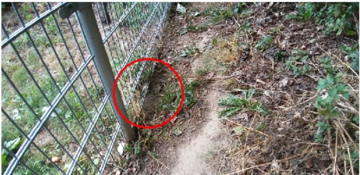
Foto 4: Doorgang onder hekwerk langs sportveld nabij dassenpijp van foto 2
