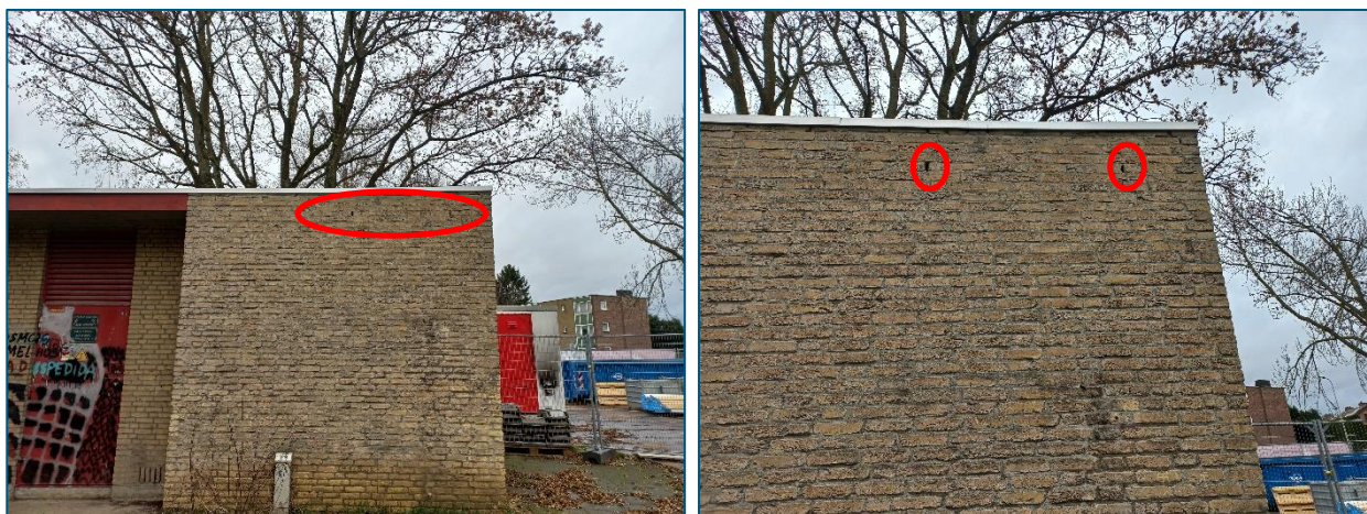
Figuur 5-3. Het transformatorhuis met potentieel voor vleermuizen geschikte verblijfplaatsen door de aanwezigheid van stootvoegen (rood omlijnd). Foto's: Royal HaskoningDHV, 2022.
