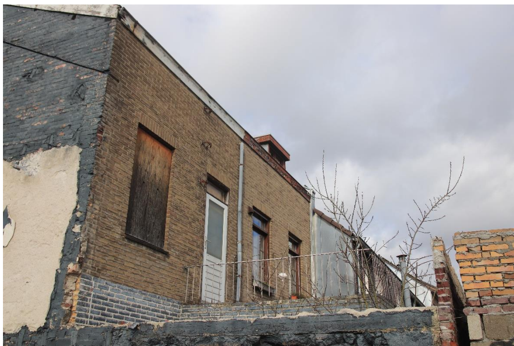
Foto 1: Beeld op de achterzijde van de woningen, nergens zijn geschikte nestlocaties voor vogels te vinden
