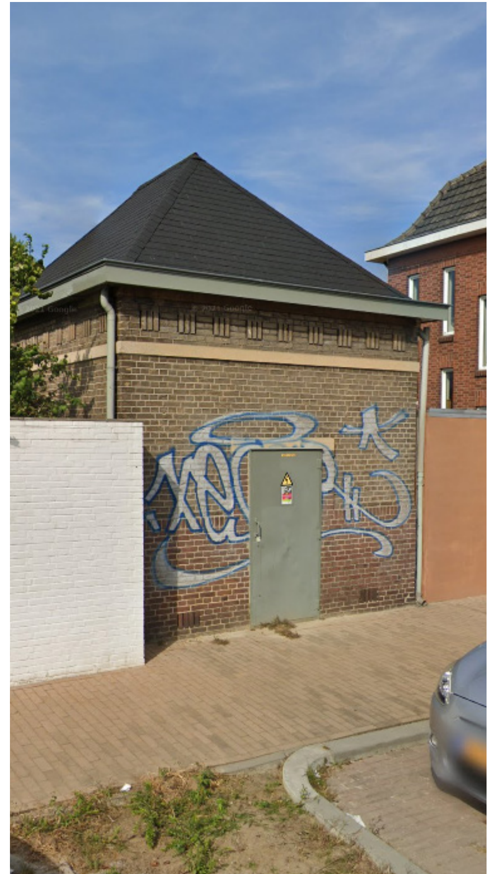
Trafohuisje Erpostraat: beeldbepalend element/pand
