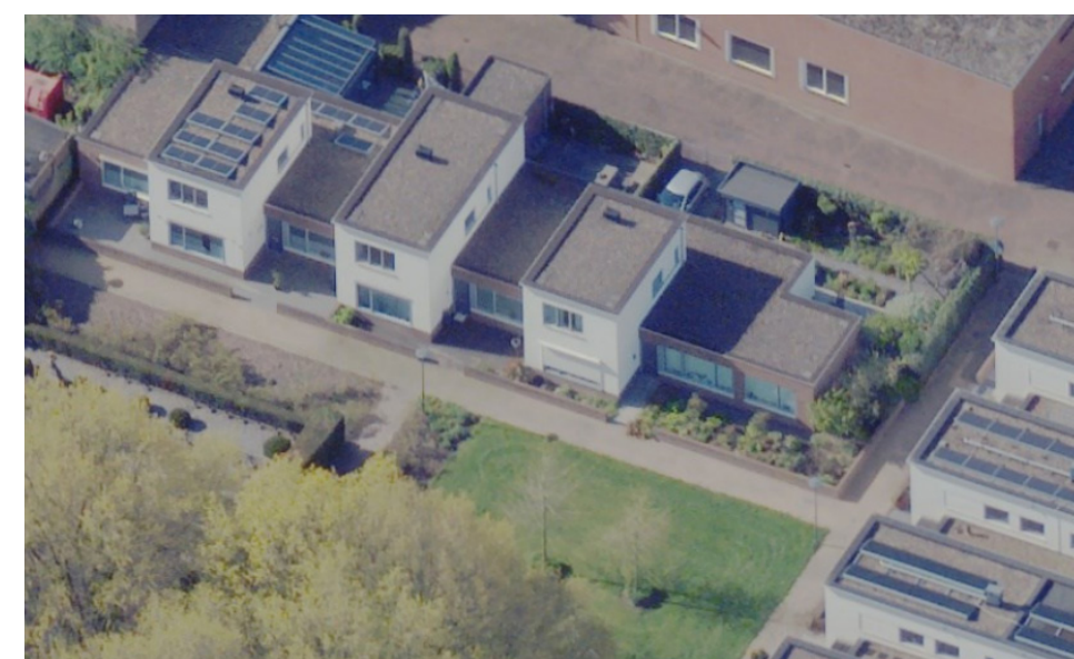
Referentie Kerkrade: gemetselde muurtjes pationwoningen Holzstraat
