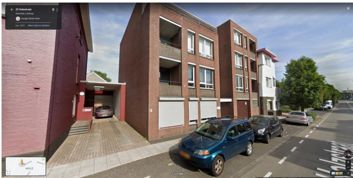
Figuur 4: Uitzicht op de voorgevel van complex 10314 aan de Holzstraat. Het witte pand rechts daarvan betreft complex 10324 aan de Erpostraat.
