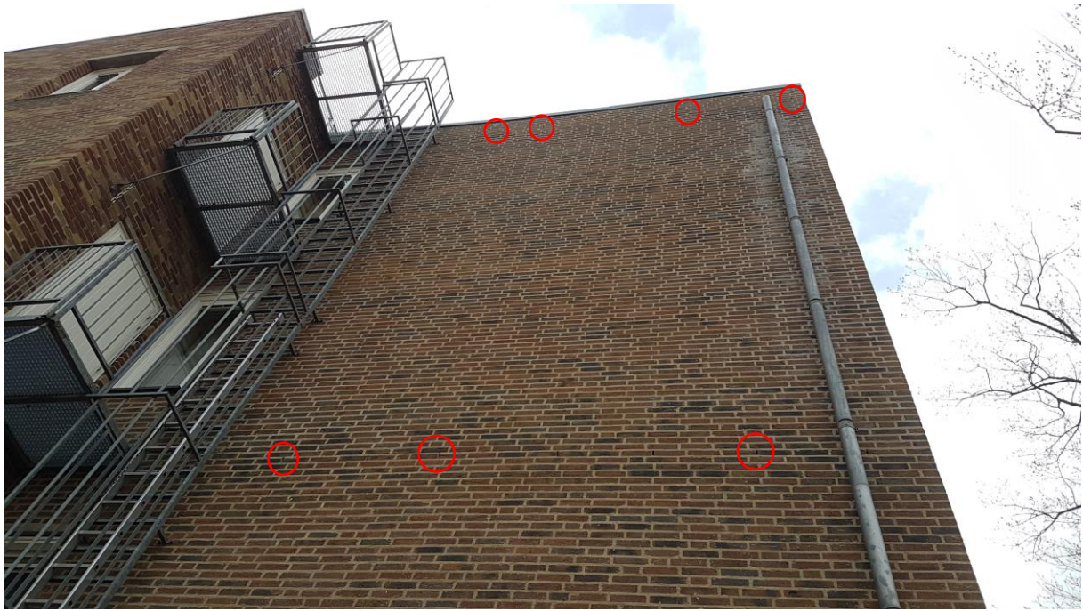
Foto 9: in de muur ten westen van de onderzoekslocatie zitten meerdere openstootvoegen (enkele aangegeven) die potentieel geschikt zijn voor vleermuizen. Ook kunnen kleine holtes gebruikt worden door de gierzwaluw om in te broeden.
