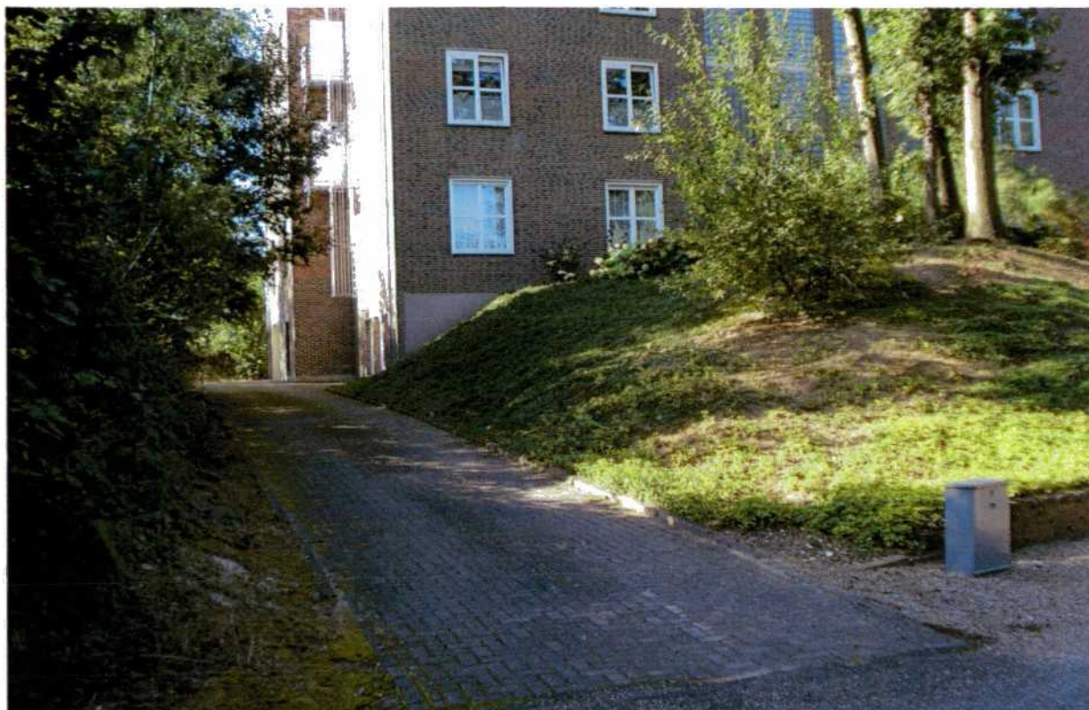
Overzicht op gebouw 2 (vanaf Schovetweg)
