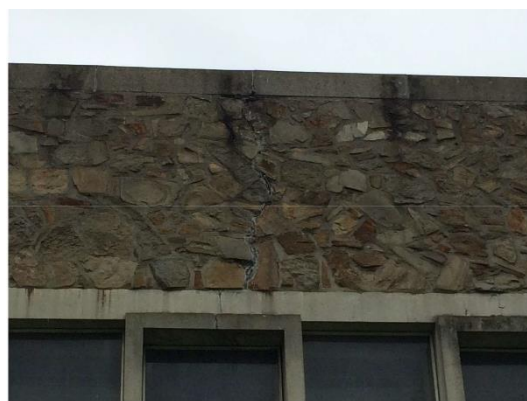
Figuur 8: scheurvorming in de buitenmuur
