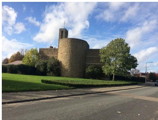
Figuur 4: Kerkgebouw gezien vanuit oostelijke richting.
