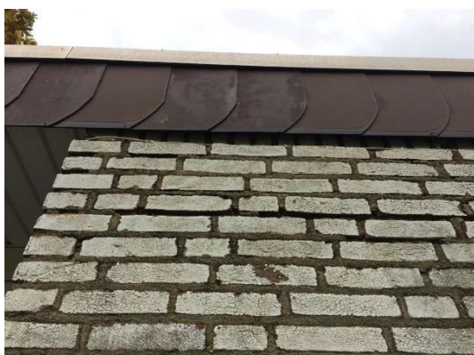
Figuur 11: Kierende boeiboorden bij de aangelegen woningen.
