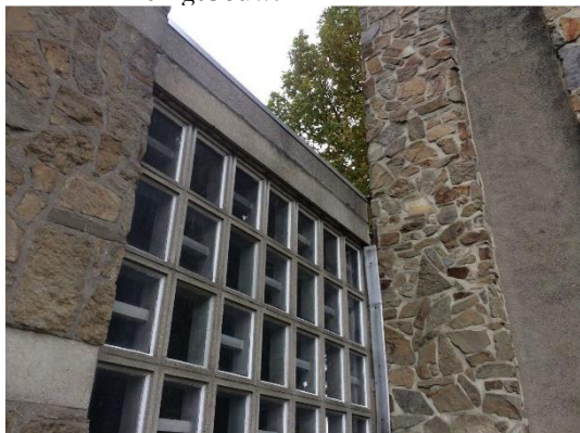
Figuur 9: Aluminium daktrim bij plat dak zuidelijk deel van het kerkgebouw.
