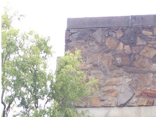
Figuur 7: Schade aan metselwerk en de betonnen
