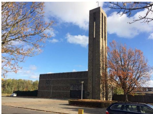
Figuur 3: Kerkgebouw en klokkentoren gezien vanuit westelijke richting.
