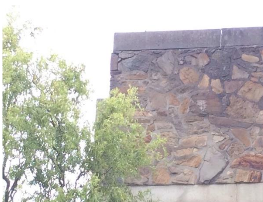
Figuur 6: Schade aan metselwerk en de betonnen dakrand aan de zuidwesthoek van het kerkgebouw.
