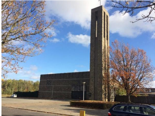
Figuur 2: Kerkgebouw en klokkentoren gezien vanuit westelijke richting.
