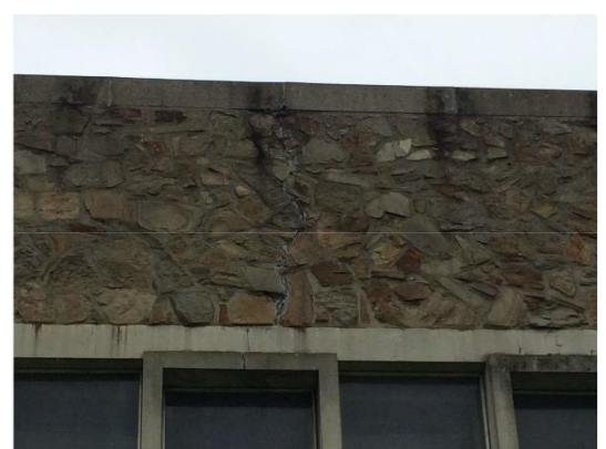
Figuur 7: scheurvorming in de buitenmuur boven de raampartij in de noordgevel van het kerkgebouw.
