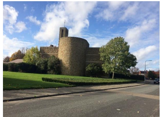
Figuur 3: Kerkgebouw gezien vanuit oostelijke richting.
