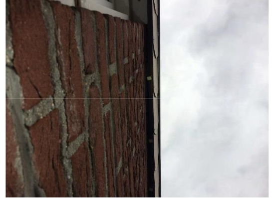
Figuur 11: Ruimtes tussen boeiboorden en buitenmuur.
