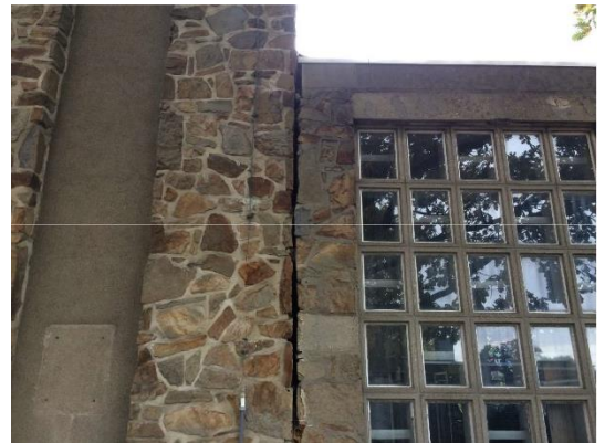
Figuur 9: Open dilatatievoeg tussen kerkgebouw en klokkentoren.
