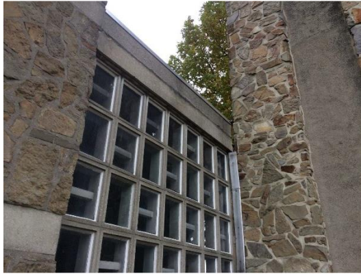
Figuur 8: Aluminium daktrim bij plat dak zuidelijk deel van het kerkgebouw.
