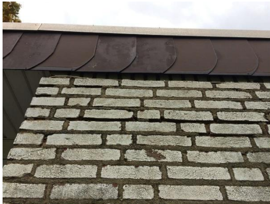
Figuur 10: Kierende boeiboorden bij de aangelegen woningen.
