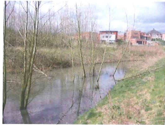
Figuur 10: Aan de voet van het talud van de N299 nabij de Tichelstraat bevindt zich een regenwaterbuffer.
