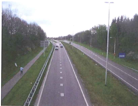
Figuur 11: De N299 ter hoogte van Vink. Westelijk van de Kloosterbosstraat heeft de N299 brede grazige bermen. Op de taluds is vaak bos aangeplant.
