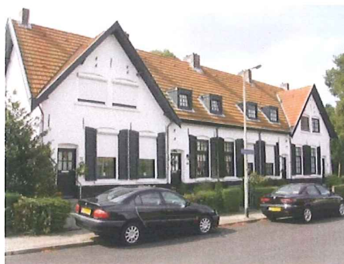
Figuur 4: Woningen in de voormalige mijnwerkerskolonie Hopel (Kanariestraat).
