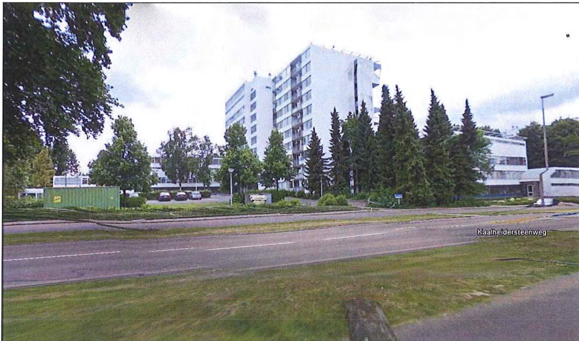
Figuur 5: Hoogbouw uit de jaren zeventig van de vorige eeuw op het noordelijke deel van het plangebied tussen de Gladiolenstraat en de Kaalheidersteenweg, gezien vanaf de Kaalheidersteenweg. De flats zijn inmiddels gesloopt.
