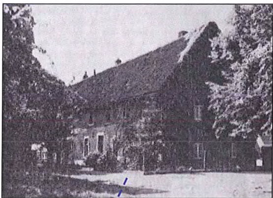
Figuur 21: Afbeelding van de verdwenen hoeve Speckholz
