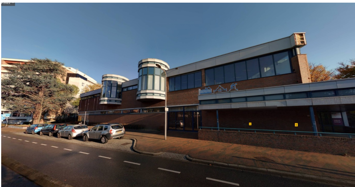
Huidige langgerekte gevel complex D'r Pool met veel glas op met name de eerste verdieping
