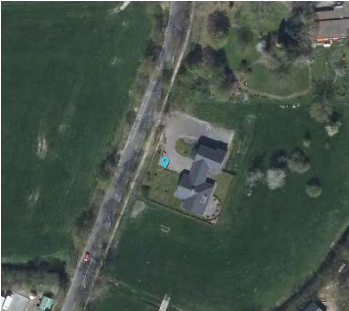
Luchtfoto huidige situatie ter plaatse. Bron: www.ruimtelijkeplannen.nl .
