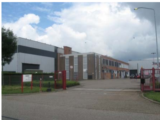
Figuur 3: Fabrieksgebouwen aan de Ingenieur van Dieststraat.
