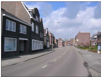
Lintbebouwing langs de Nieuwstraat
