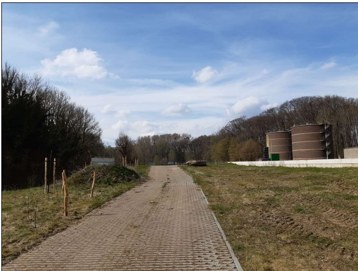
Figuur 5: Zicht op de toegangspad (grasbeton).
