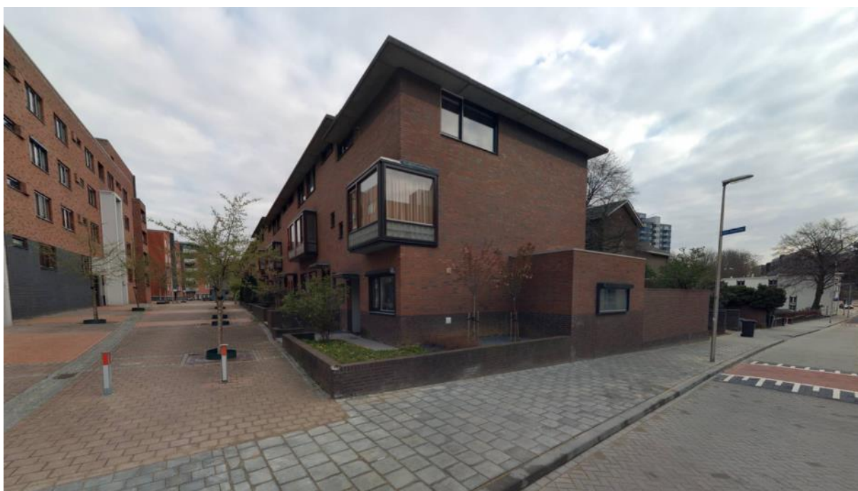
Woningen aan de Deken Bemelmansstraat met rechts de projectlocatie
