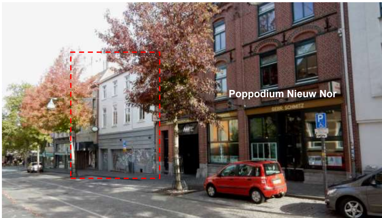
Figuur 6: Oostzijde Pancratiusstraat. De te slopen panden Studio 54 (huisnr. 38) en het Kegelpaleis (huisnr. 30) zijn rood omkaderd. Foto: R. Paulussen, 12-07-2017
