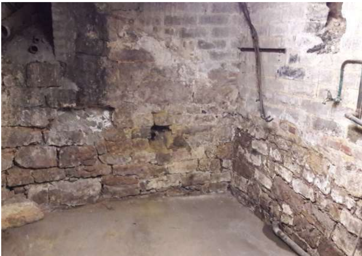
Figuur 19. Oude muurresten in de kelder onder het pand Studio 54 (Pancratiusstraat 38). Foto: L. Moonen, gemeente Heerlen)
