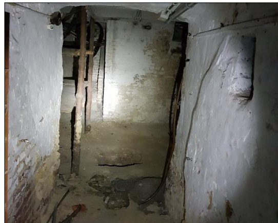
Figuur 11. Kelder Pancratiusstraat 32-34
