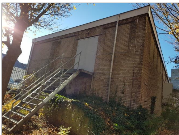
Figuur 8. Achterzijde Pancratiusstraat 36-44
