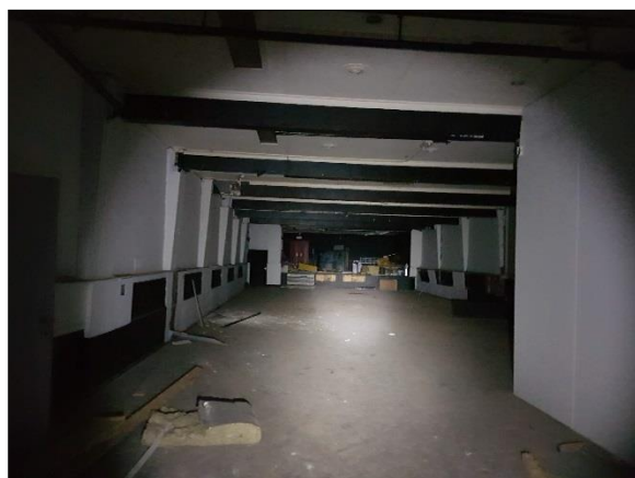
Figuur 9. Binnenzijde Pancratiusstraat 36-44
