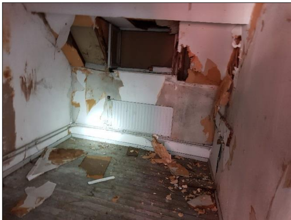
Figuur 10. Binnenzijde Pancratiusstraat 32-34
