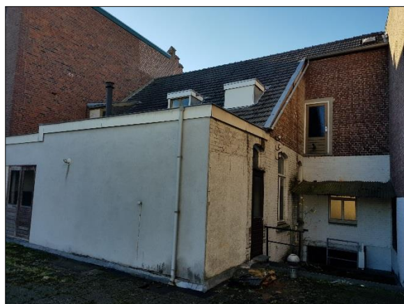
Figuur 7. Achterzijde Pancratiusstraat 32-34
