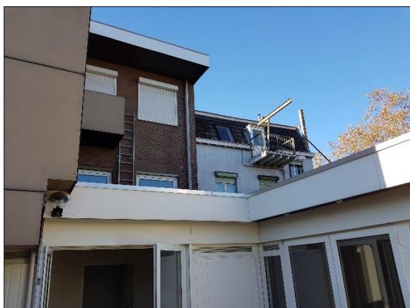
Figuur 6. Achterzijde Pancratiusstraat 36-44
