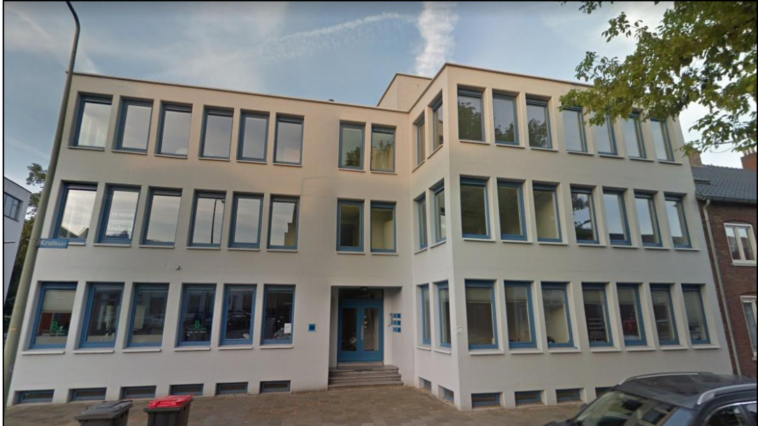
Voorgevel Kruisstraat 80 (bron: Google StreetView)
