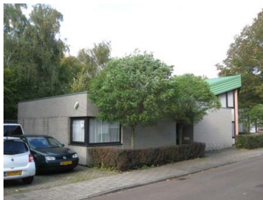
Figuur 8: Kantoorgebouw aan de Donderdagstraat.
