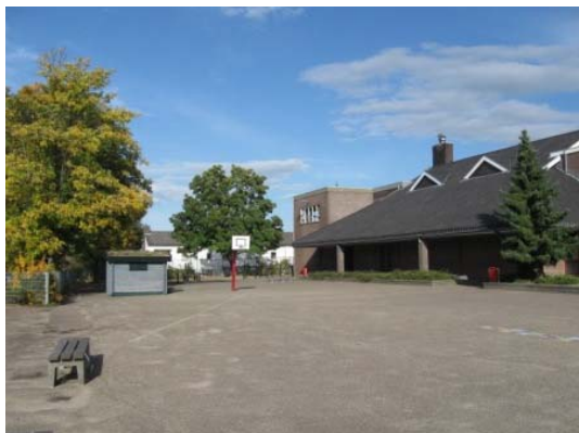
Figuur 5: De speelplaats voor de Broederschool, gezien in noordelijke richting.
