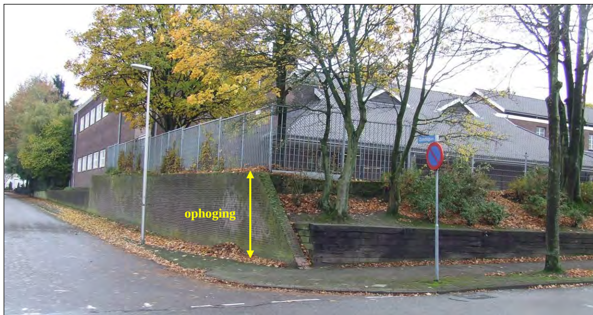
Figuur 25: De noordwestelijke hoek van het plangebied (hoek Zondagstraat-Holle Weg) met de Broederschool. Hier is duidelijk te zien dat het plangebied door de oorspronkelijke noordwest gerichte helling ten behoeve van de bouw tot meer dan 2 meter lijkt te zijn opgehoogd.
