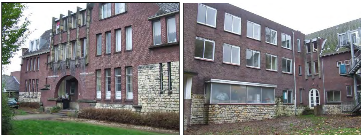
Figuur 22: Voor- en achterzijde van het Broederhuis
