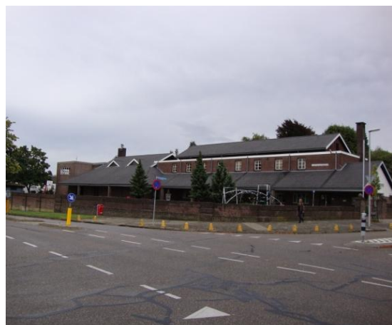
De westgevel van de Broederschool
