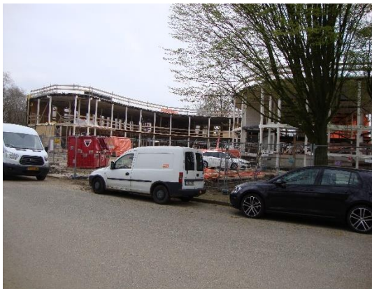
De in aanbouw zijnde BMV Hoensbroek Zuid
